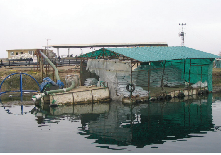
Şekil 4. Karada kurulan bir yem deposundan ve idari bina tesisinden bir görüntü
