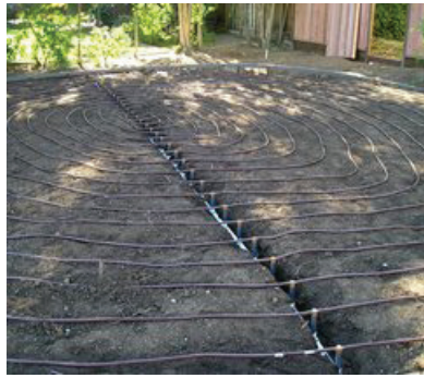
Şekil 5. Kurakçıl peyzaj uygulamalarında kullanılan yüzey altı damla sulama sistemi (Kaynak: Anonim, 2023h)
