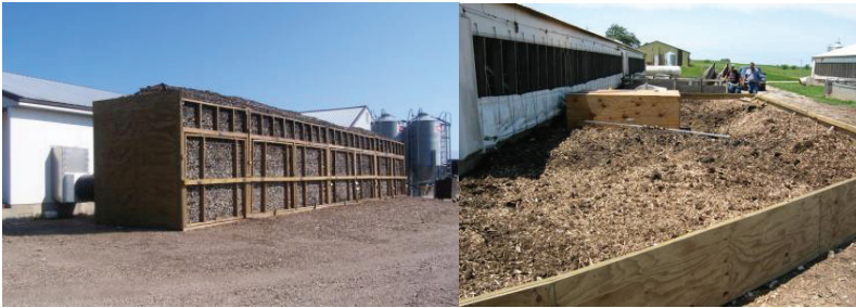
Şekil. 9. Hayvan barınaklarındaki biyofiltre sistemleri
