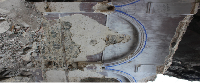
Resim 27. Güney Duvar, Zincir Motifi (2022)
