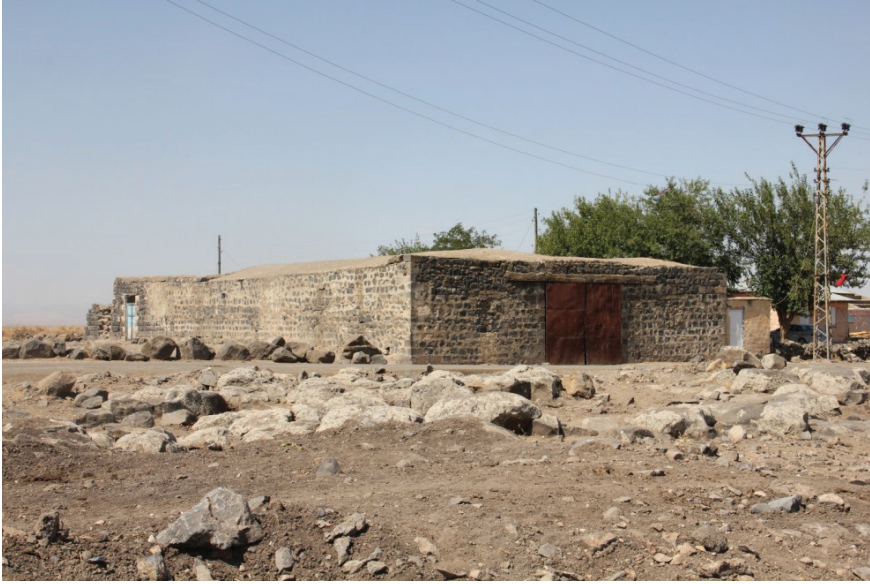
Foto:4- Han-ı Gevran'ın Güneybatı Cephesi.
