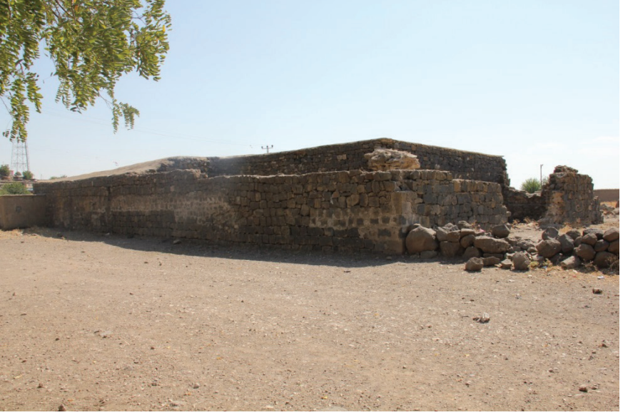
Foto: 6- Han-ı Gevran'ın Kuzeydoğu Cephesi.
