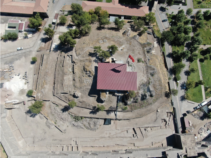
Fotoğraf:4: Diyarbakir İçkale Artuklu Sarayı Kazısı 2021 Sezonu Çalışmaları Tamamlandıktan Sonundaki Durumu.
