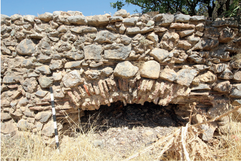
Foto 14: Yapının kuzey yönündeki kemer açıklığı
