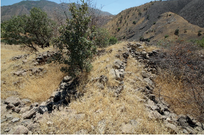
Foto 7: Kalenin içinde yer alan mekânların temel seviyesindeki duvar görünümüleri
