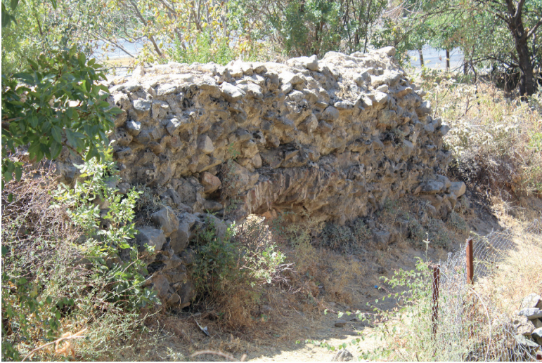
Foto 17: Yapının kuzey cephe görünümü
