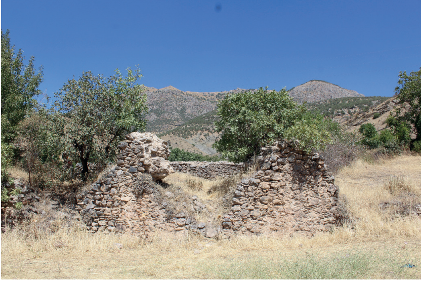
Foto 16: Yapının güney bölümdeki yıkılmış bölümler
