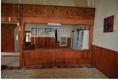
Resim 23: Müezzin mahfilinin görünüşü
