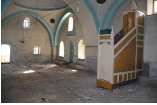
Resim 46: İç mekan görünüşü
