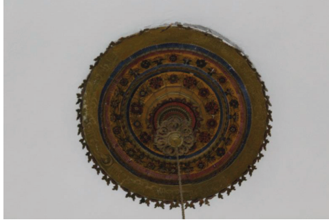
Resim 12: Kubbedeki şemse motifinin görünüşü
