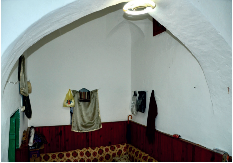
Fotoğraf-12 Sitti Zeynep Tekke ve Türbesi Zaviye Mekâni Güney Cephe
