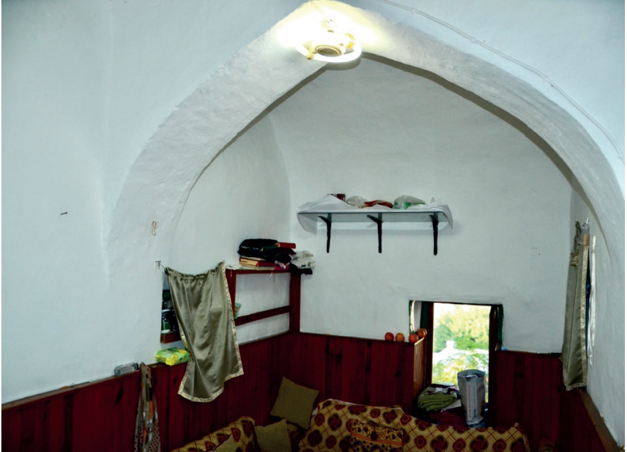
Fotoğraf-13 Sitti Zeynep Tekke ve Türbesi Zaviye Mekâni Kuzey Cephe
