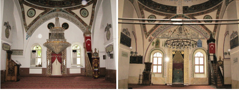
Resim 4-5: Uşak Ulu Cami. Restorasyon öncesi ve sonrası harim güney duvarı (10.09.2014-19.12.2021).
