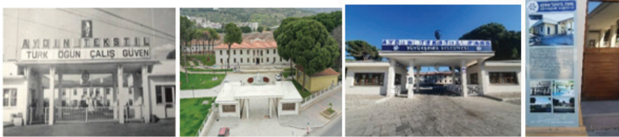
Şekil 11. Fabrikanın anıtsal ana giriş kapısı, 1962 (Kaynak: Kolsal, 2015: 128), meydana restorasyon öncesi ana girişten görülen Atatürk büstü ve idari bina (Kaynak: URL2), ana kapının restorasyon sonrası hali ve bilgilendirme tabelası, 2022 (Kaynak: S. Baysan Arşivi)
