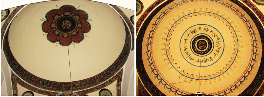
Resim 7-8: Uşak Ulu Cami. Restorasyon öncesi (10.09.2014) ve sonrası harim merkezî kubbesi (19.12.2021).
