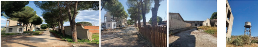
Şekil 17. Aydın Tekstil Fabrikası restorasyon öncesi ve sonrası Kantar yapısı, Kazan Dairesi, Trafo Merkezi ile pamuk indirme rampası, çeşitli atölyeler ve yolun en sonunda itfaiye, son resim Su Deposu 2021, 2022 (Kaynak: S.Baysan Arşivi)
