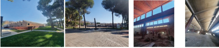
Şekil 22. Restorasyon sırası ana üretim binası çevresi ve içerisi, 2022 (Kaynak: S.Baysan Arşivi)
