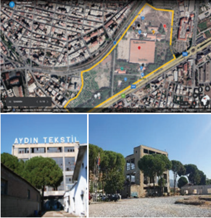
Şekil 9. Aydın Tekstil'in 48m'den hava fotoğrafı (Kaynak: Google Earth ile haz.) ile Kazan Dairesi üzerindeki Aydın Tekstil yazısı, 2008 (Kaynak: Kolsal: 2015: 67) ve 2022 restorasyon öncesi (Kaynak: S.Baysan Arşivi)
