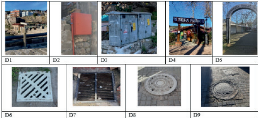
Şekil 11. Çalışma alanında tespit edilen diğer donatılar
