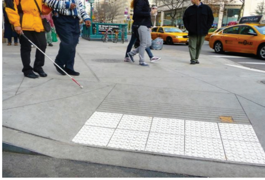
Şekil 2. Rampalar ve yüzey uygulamaları (URL 2)
