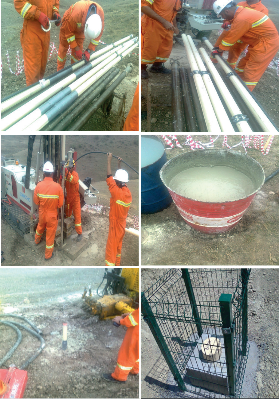
Şekil 5.2. İnklinometre borusunun kuyu içerisine yerleştirilmesi ve çimento-bentonit enjeksiyonu ile sabitlenmesi çalışmaları.
