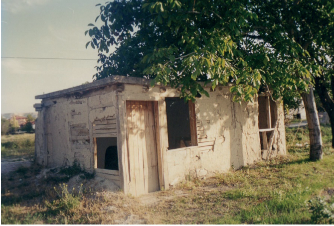
Şekil 4. Ahşap karkas bağdadi sistem üzeri kerpiç sıva tekniği kullanılan bir yapı (Cumhur Batur kişisel Fotoğraf Albümü, 1998-1999)
