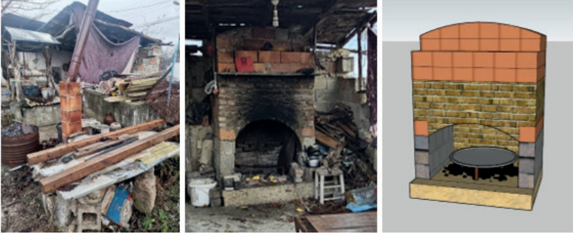
Şekil 12. Celal Bey bağdamında bulunan iki farklı ocaklık ve çizimi
