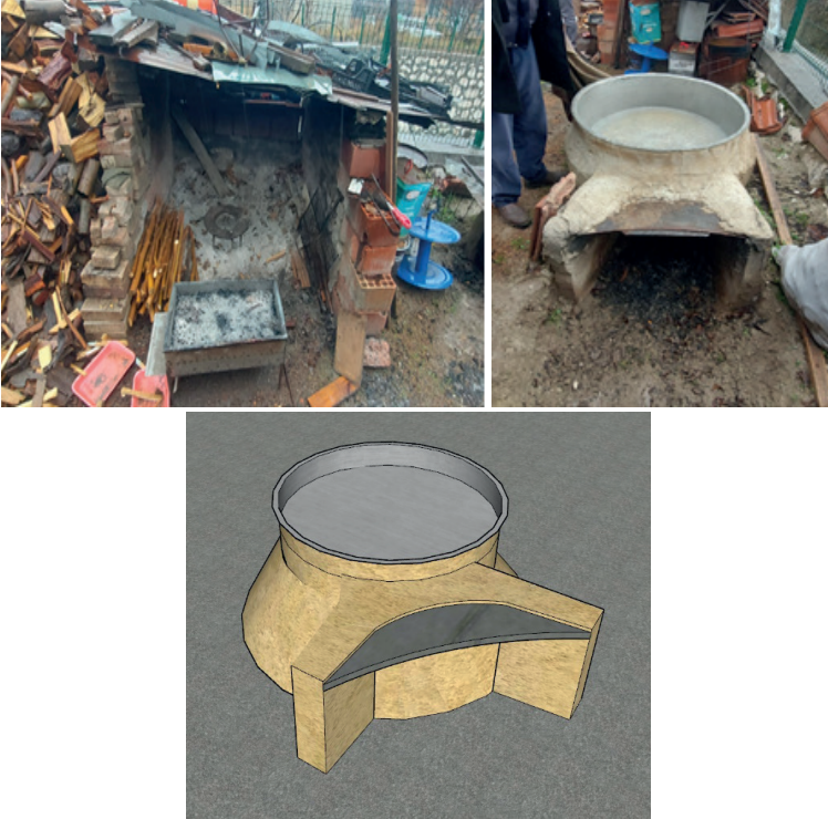
Şekil 19. Yaşar Bey evinde kazan kaynatılan ocaklık ve ocağa sabitlenmiş pekmez tavası
