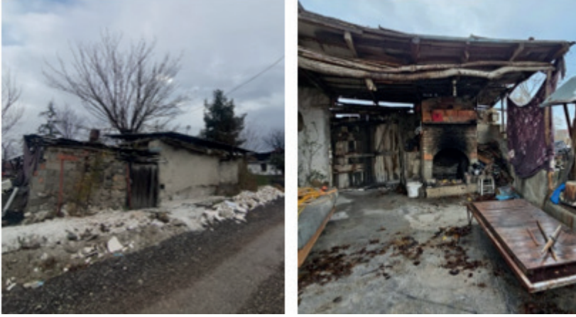
Şekil 10. Celal Bey'e ait olan bağdamımın sokaktan ve bağ içerisinden görünümü
