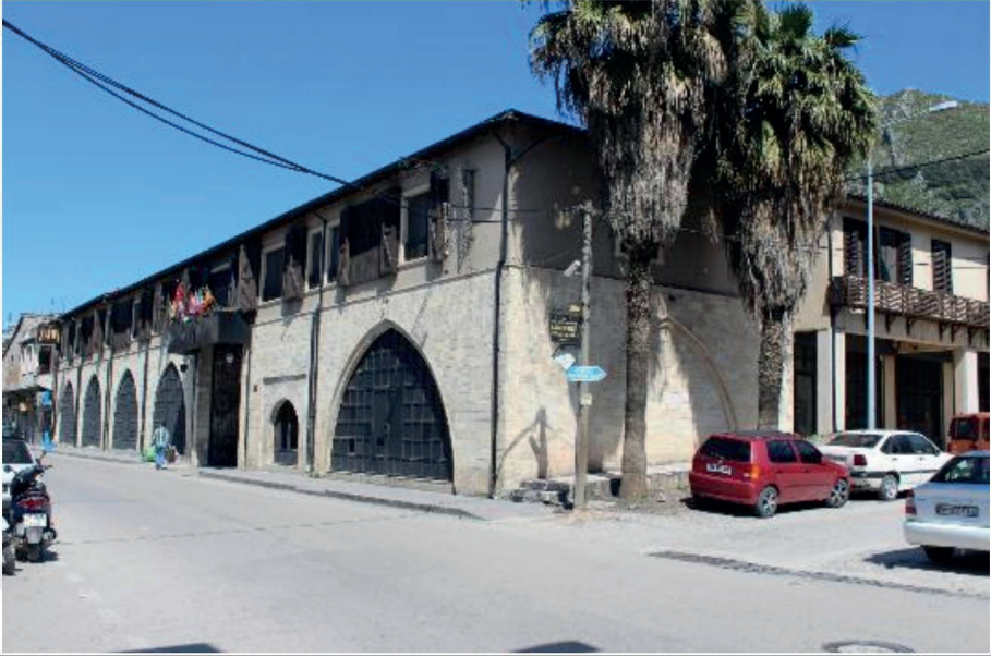
Şekil 9: Savon Sokak Cephesi (Müge Çiftiyürek Arşivi)
