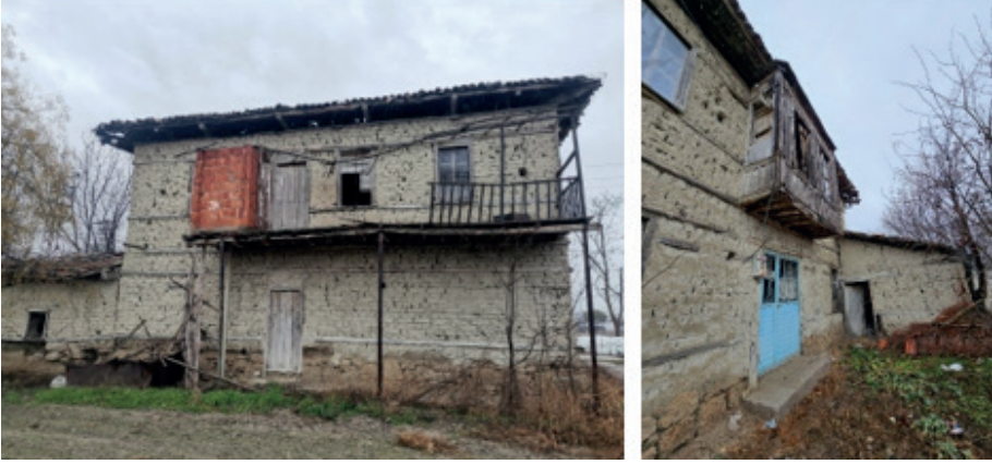
Şekil 5. Bağlar Mahallesi taş, kerpiç ve ahşap malzeme kullanılan yapılar
