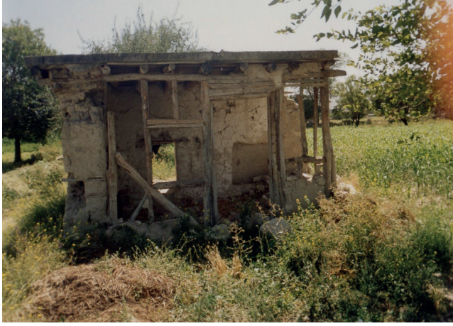
Şekil 3. Kerpiç yapıda ahşap malzemenin kullanımı (Cumhur Batur kişisel Fotoğraf Albümü, 1998-1999)
