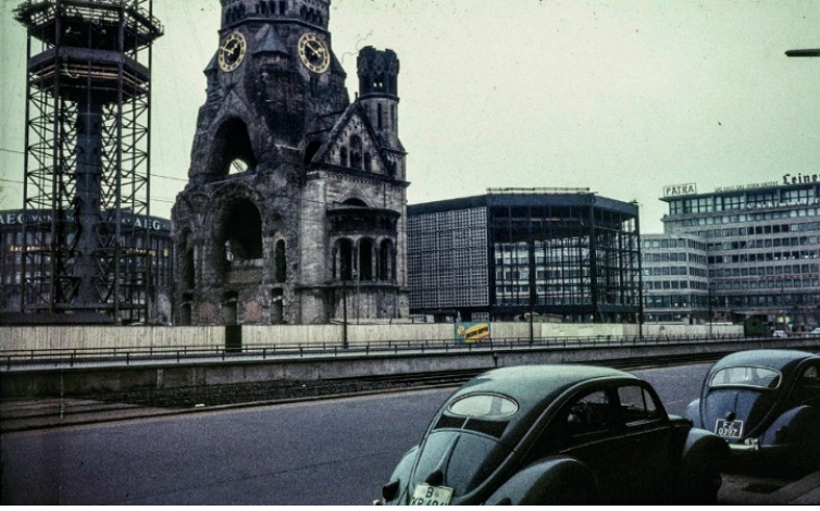
Şekil 3: Yapım aşamasında Çan Kulesinin Çelik taşıyıcı iskeleti ve Kilisenin bombardıman sonrası korunmuş hali (Jaeggi & Cantz 2004: 173).
