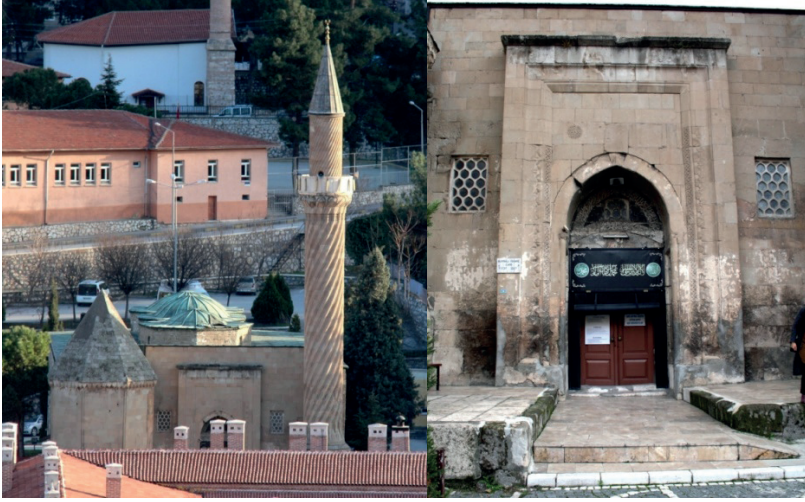
Resim 8: Burmali Minare Cami genel görünüşü ve taçkapısı
