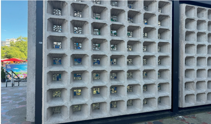
Şekil 6. Beton Precast petek, kırık cam kombinasyonu ve Çelik taşıyıcı sistem (Yazar Arşivi, 21.08.2025).
