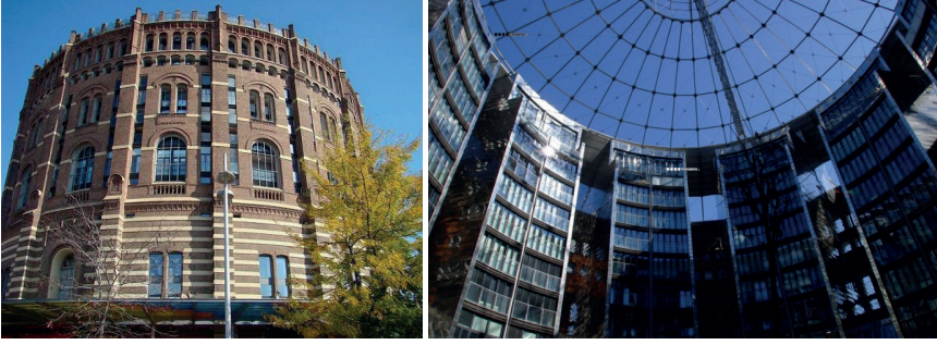
Şekil 8. Viyana Gazometreleri'nin iç ve dış cephelerinden görünüm
