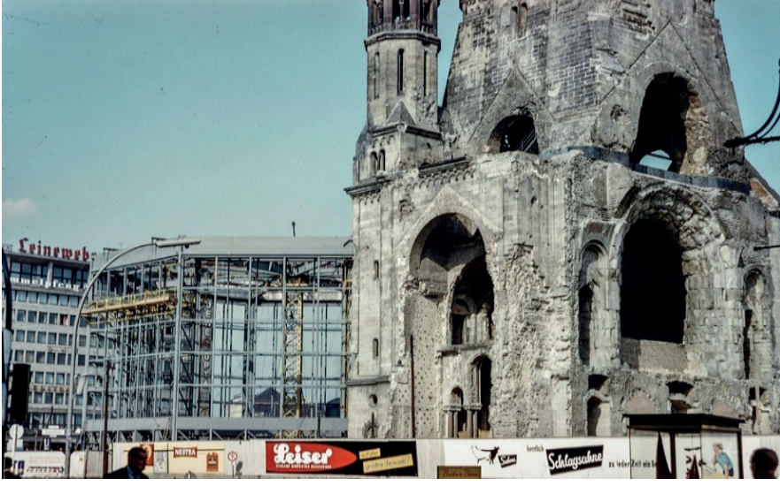
Şekil 4. Kilisenin yapım aşamasında Çelik taşıyıcı iskeletin bitmiş haliyle arkasında kalan Kilisenin özgün hali (Jaeggi & Cantz, 2004).
