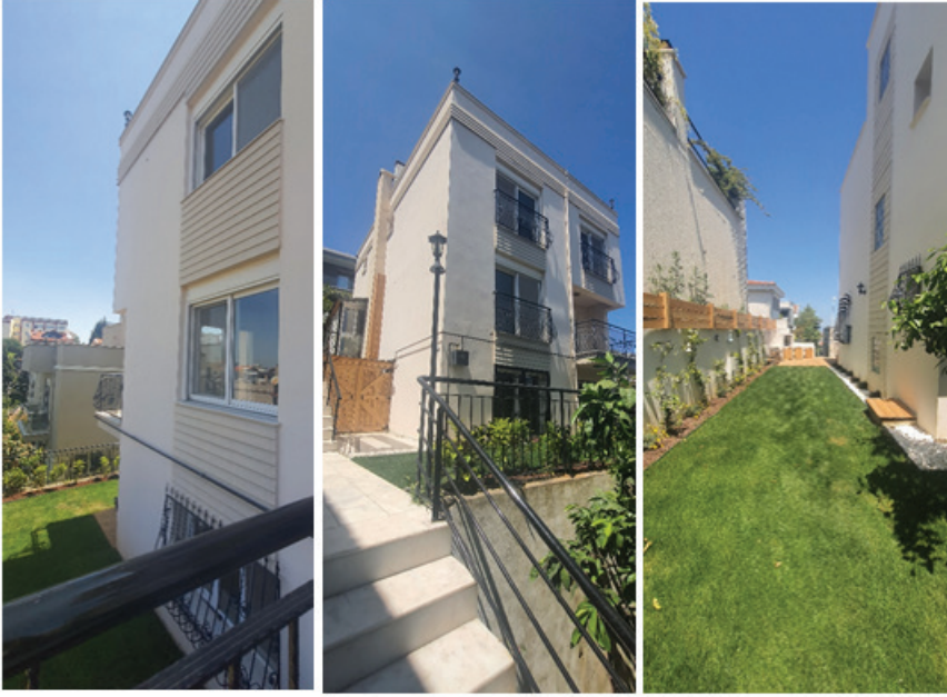
Şekil 4.a.Binanın kuzey doğu görünüşü b.Kuzey görünüşü c. Batı Cephesi(Arka cephe)
