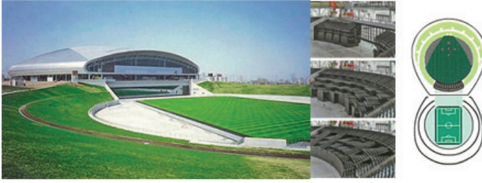
Şekil 8 . Soldan Sağa Sapporo Dome Hareketli Etkinlik Sahası, Teleskopik Tribünler ve Sistem Planı (Nixdorf, 2008)
