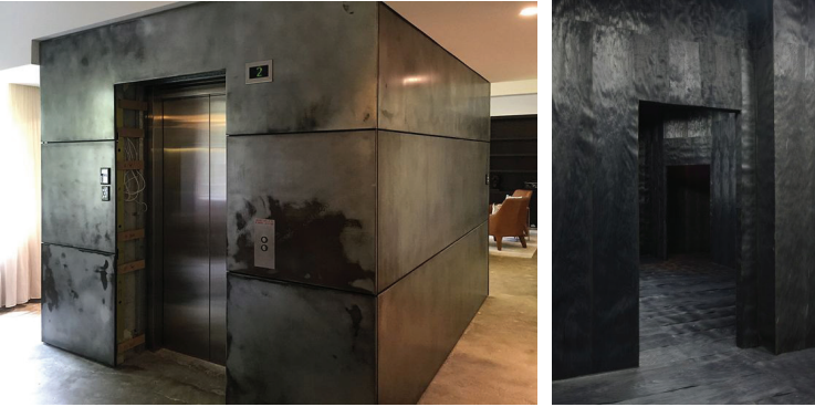
Şekil 5. İç mekanda yüzey kaplaması olarak metal kullanımı
