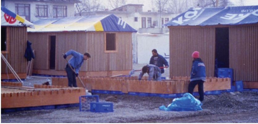
Şekil 8. Shigeru Ban Kağıt Ev Yapım Süreci
