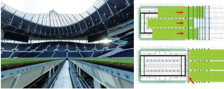
Şekil 7 . Tottenham Hotspur Stadyumu Hareketli Etkinlik Sahası Görünümü (solda) ve Çalışma Prensibi (Populous, 2019)
