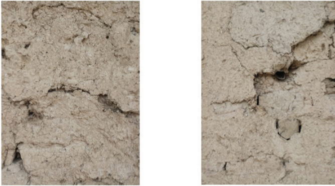
Resim 1-2: Yağmur suyu ile temas eden dış yüzeyde meydana gelen dökülmeler (Kişisel arşiv).
