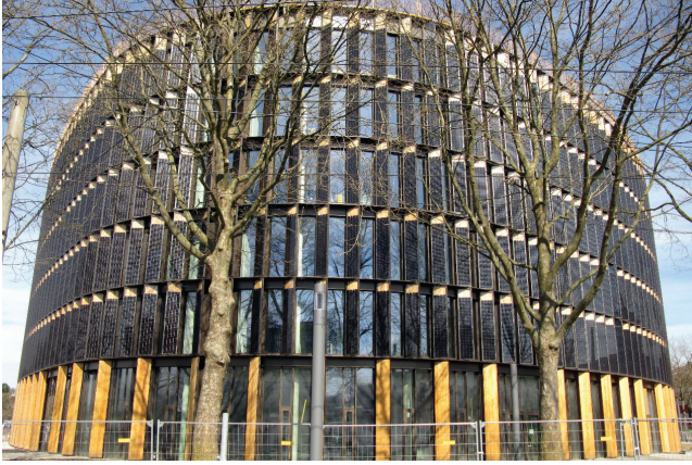
Şekil 12. Yapı cephesine entegre edilen PV paneller (Wikimedia Commons,2017, CC BY-SA)
