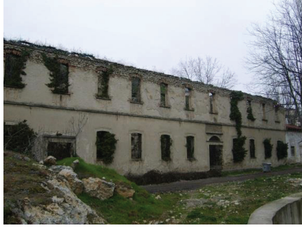
Şekil 9. Tabakhane Binası Mevcut Durum (Korumaz & Özeren, 2019)
