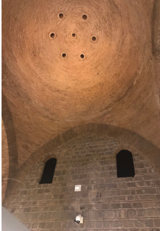
Görsel 5..Kurşunlu Han restorasyon çalışmalarından fotoğraf.
