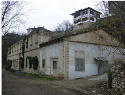
Şekil 7. Tabakhane Binası Mevcut Durum (Korumaz & Özeren, 2019)
