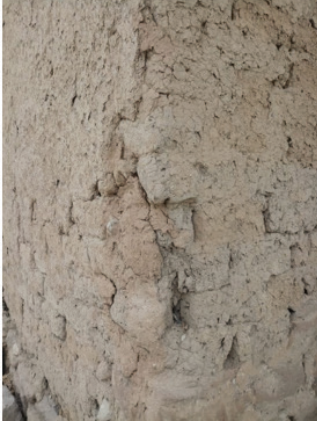
Resim 3: Darbelere karşı dayanıksızlık örneği.
