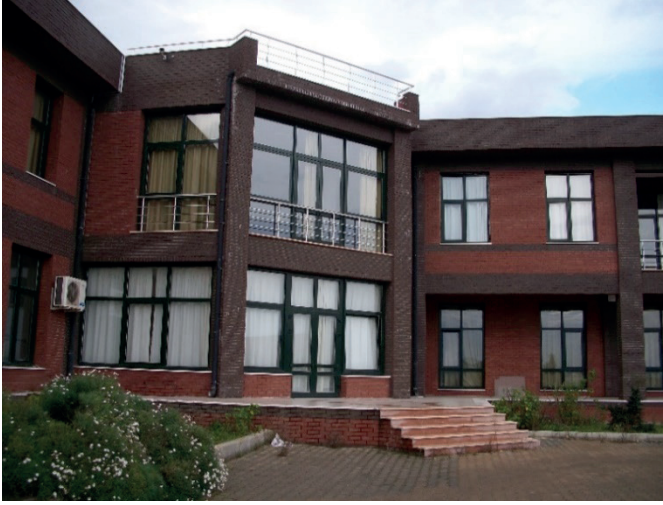
Resim 12. İYTE Fizik Bölümü, kuzeyden kantin girişi görünümü. (Foto: A.C. Benli. 2011)
