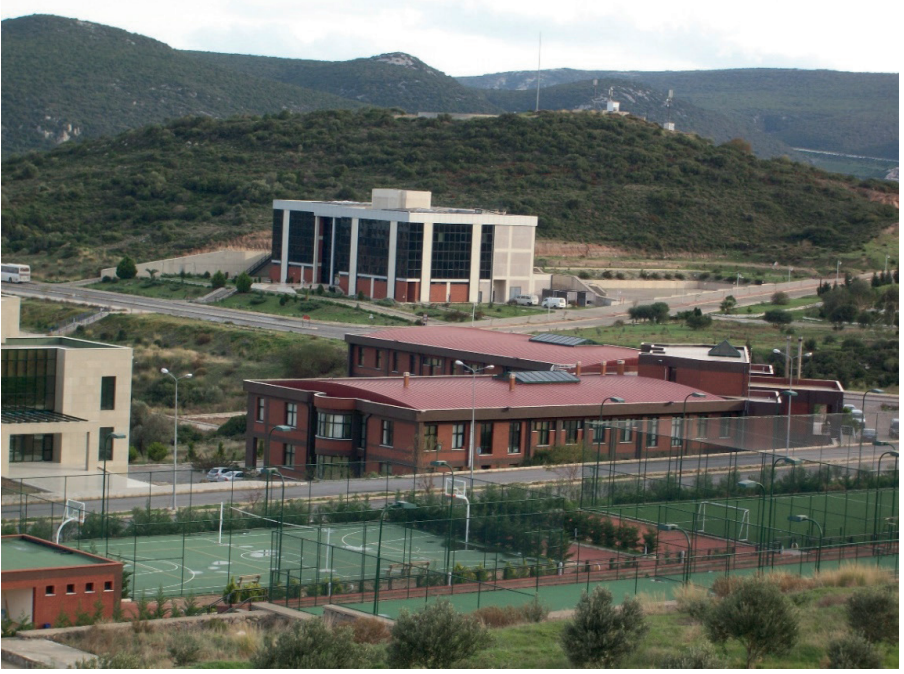
Resim 3. İYTE Fizik Bölümü yapısı, güneybatıdan görünümü. Sağ üstte yemekhane yapısı. (Foto: A.C. Benli. 2010)
