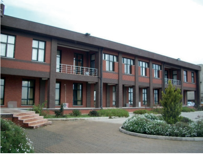
Resim 11. İYTE Fizik Bölümü, kuzeydoğudan altta laboratuvarlar, üstte öğretim üyeleri odaları dış görünümü. (Foto: A.C. Benli. 2011)
