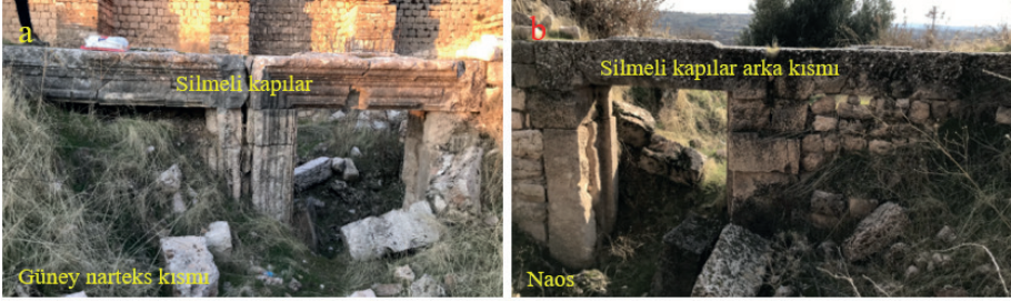
Resim 8. Kilise naosundan güney narteks kısmına geçiş sağlayan silmeli kapılar (a, b)
