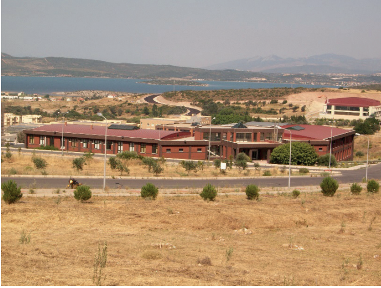
Resim 2. İYTE Fizik Bölümü yapısı, güneyden görünümü. Sağ üstte kapalı spor salonu yapısı. (Foto: A.C. Benli, 2010)
