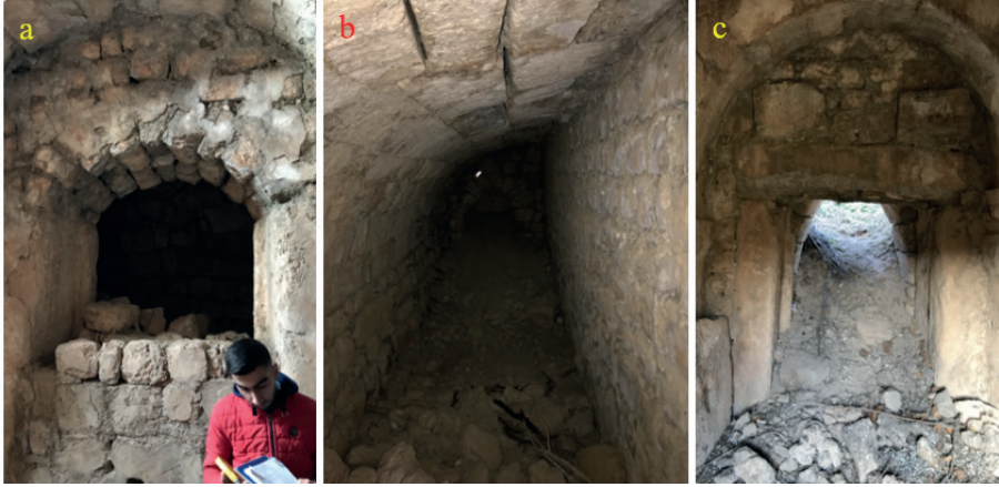
Resim 6. Narteksin kuzey duvarındaki kapı açıklıkları (a, c), yarım tonozla örtülü dar alan (b)
