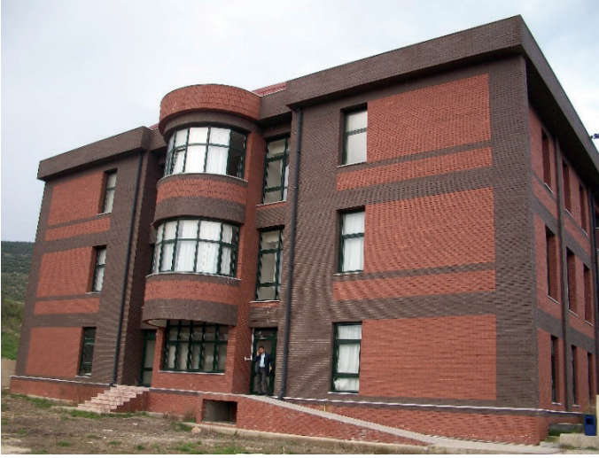
Resim 14. İYTE Fizik Bölümü yapısı, kuzeydoğu görünümü. (Foto: A.C. Benli. 2011)
