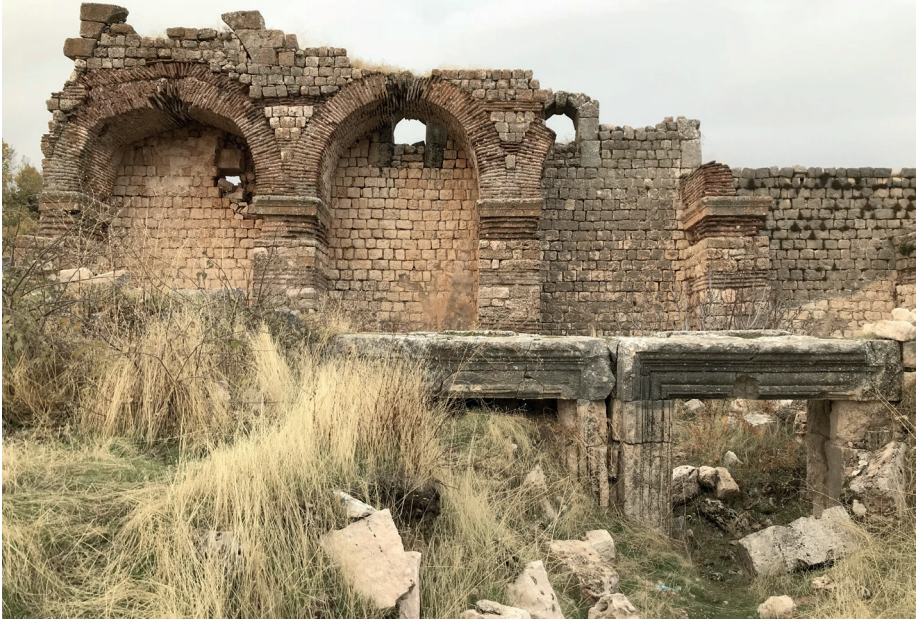
Resim 3. Naosun kuzey duvarı
