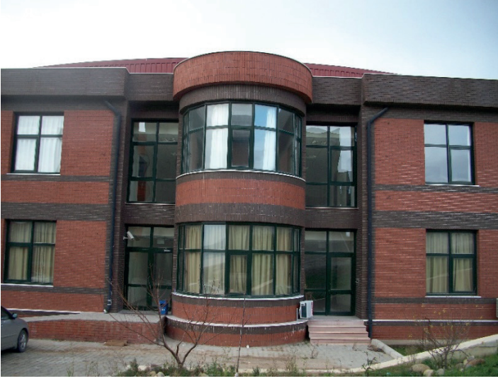
Resim 15. İYTE Fizik Bölümü yapısı, kuzeybatı görünümü. (Foto: A.C. Benli. 2011)
