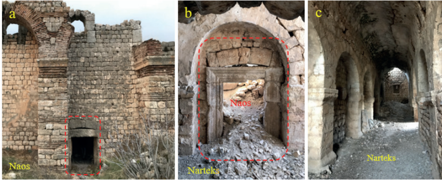
Resim 5. Naos kuzey duvarından kuzey nartekesine geçilen iki kapı (a, b), kuzey narteksi (c)
