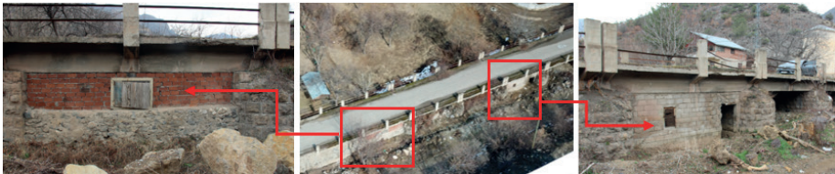
Şekil 37. Mansap Cephesi İlk/Büyük Kemer Sol Tarafının Devamındaki Moloz Duvar Örgüsü ve İnce Yonu Bosajlı Kaba Taş Ayaklar (Selyaranlar)
