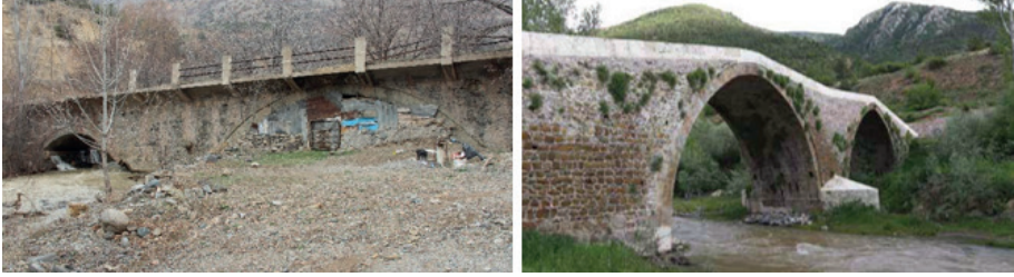
Şekil 50. Harava (İkisu) Köprüsü ve Tohumoğlu Köprüsü
