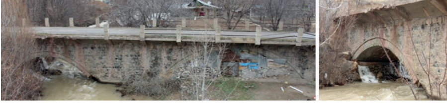
Şekil 21. Harava (İkisü) Köprüsü Mansap Cephesi İlk Kemer Açıklığı
