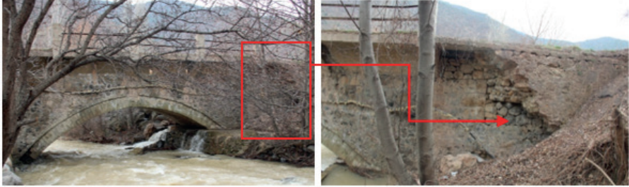
Şekil 14. Memba Cephesi Batı Tarafı Kara Bağlantı Noktası ve Tempan Duvarlarında Farklı Zamanlarda Yapılmış Örgü Düzenleri
