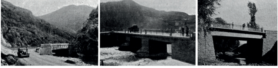
Şekil 55. Harşit Geçidindeki Düzenleme ve Eski Ayaklar Üzerine Yeni Düzenleme ve Güçlendirilmiş Beton Köprü (Cramer, 1940)
