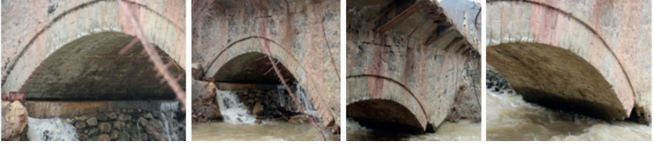
Şekil 28. Harava (İkisü) Köprüsü İlk/ Küçük Kemer, İnce Yonu Kemer-Karın Taşlarının Mansap Cephesinden Oturma Düzenine Bakış
