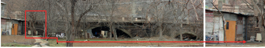
Şekil 33. Memba Cephesinde Kaba Yonu Taş Çıkıntılı Tempan Duvar Detayı
