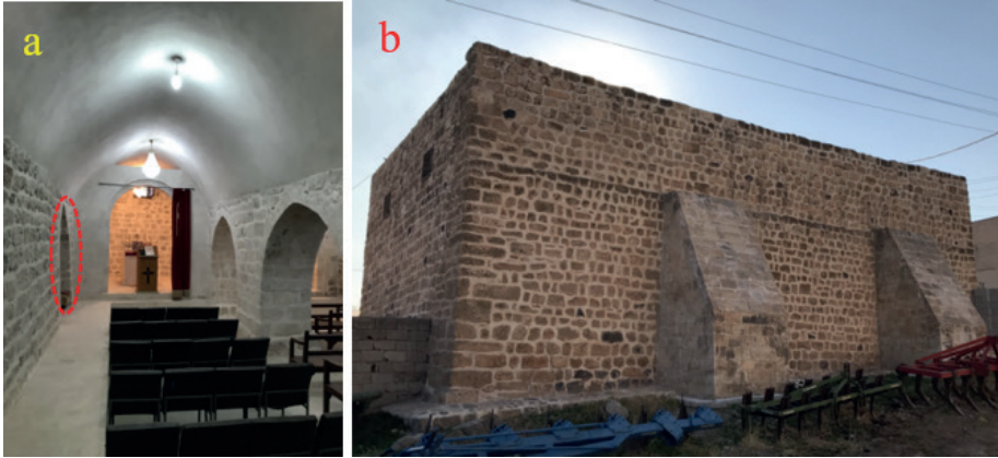
Resim 19. Naos ve kuzey duvarı (a), kilisenin kuzey cephe duvarı ve payandalar (b)
