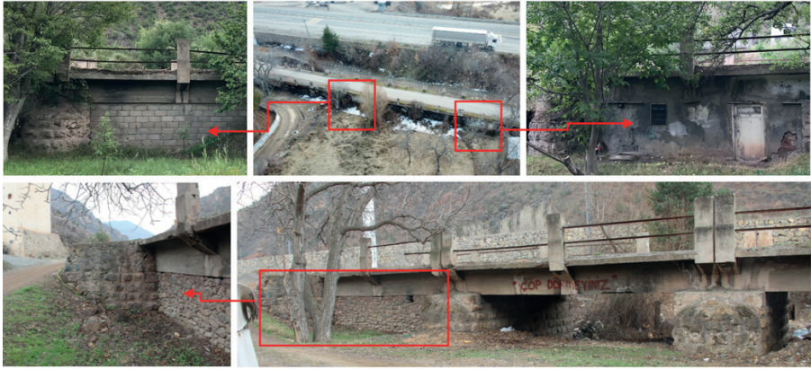
Şekil 16. Harava (İkisü) Köprüsü Mamba Cephesinde Dönem Eki Olarak Uzatılan Bölümü ve Muhdes İlavelerle Kapatılan Açıklıkları ve Doğu Kara Bağlantı Noktası
