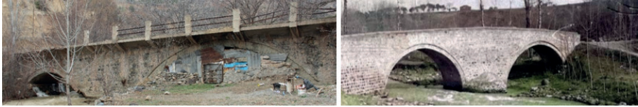
Şekil 53. Harava (İki-su) Köprüsü ve Osmanbaba (Galanima) Köprüsü'nün (1960) Eski Görünümü (URL-5, 2022)
