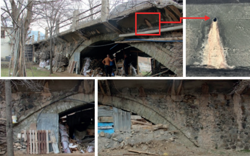
Şekil 31. İkinci/Büyük Kemer, Memba - Sol/ Mansap Sağ Tarafında Görülen Moloz Duvar Örgüsü
