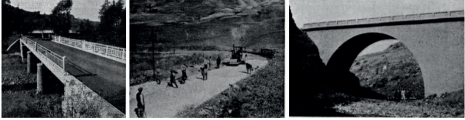
Şekil 56. Yeni Yapılan Tipik Betonarme Köprü, ve Betonarme Kemer Yaylı Viyadük (Cramer, 1940)
