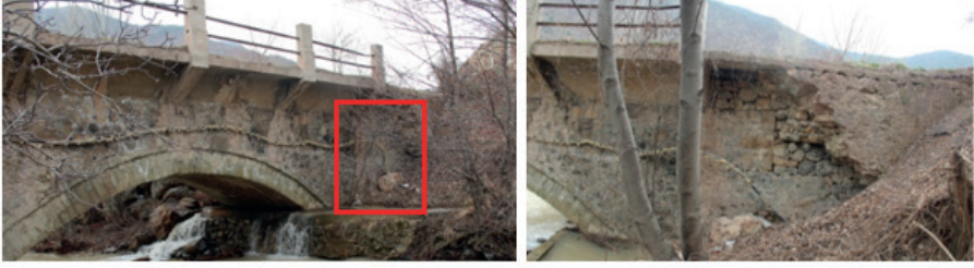
Şekil 32. Memba Cephesi Batı Karayla Bağlantı Noktasındaki Çıkıntılı Tempan Duvar Yüzeyi
