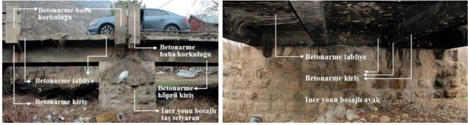
Şekil 49. Harava (İkisu) Köprüsü Memba Cephesinde Kullanılan Malzeme ve Teknikler
