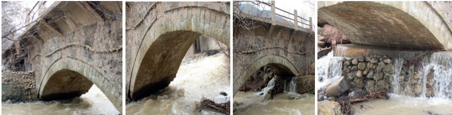
Şekil 27. Harava (İkisü) Köprüsü İlk/ Küçük Kemer, İnce Yonu Kemer-Karın Taşlarının Memba Cephesinden Oturma Düzenine Bakış
