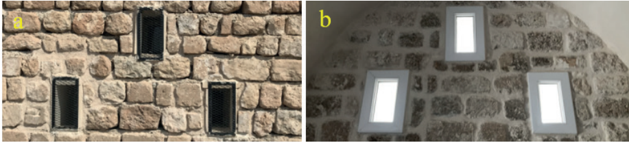
Resim 16. Naosun batı cephesinde/duvarındaki üçlü pencere (a, b)
