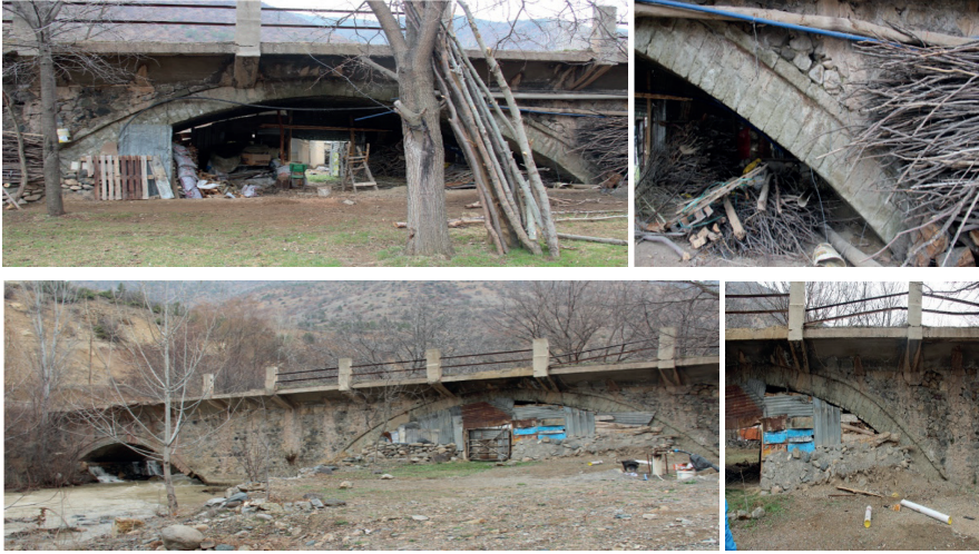
Şekil 29. Harava (İkisü) Köprüsü İkinci/ Büyük Kemer, Kemer Taşlarının Memba-Sağ ve Mansap -Sağ Cephesinden Oturma Düzenine Bakış
