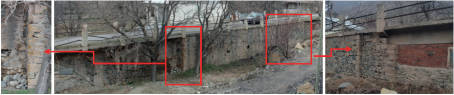
Şekil 36. Mansap Cephesi İkinci/Büyük Kemer Sağ Tarafının Devamındaki Moloz Duvar Örgüsü ve Çıkıntılı Yüzeylerin Köşe Başlangıçları
