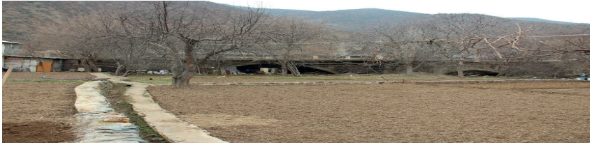
Şekil 11. Memba Cephesindeki Kemer Gözlerinin Görünümü
