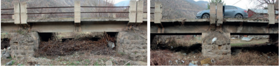
Şekil 26. İnce Yonu Bosajlı Taş Ayak ve Üzerindeki Çiftli-Açıklık Arası Tekli Betonarme Baba-İki Sıra L Profilli Demir Korkuluk Detayları
