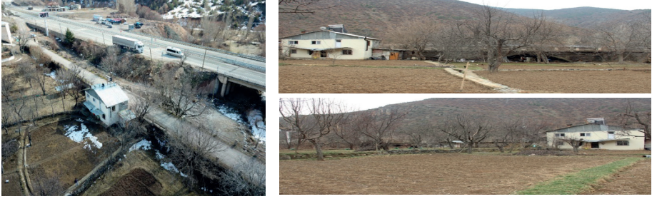
Şekil 15. Harava (İkisü) Köprüsü Mamba Cephesinde Köprüye Bitişik Ev
