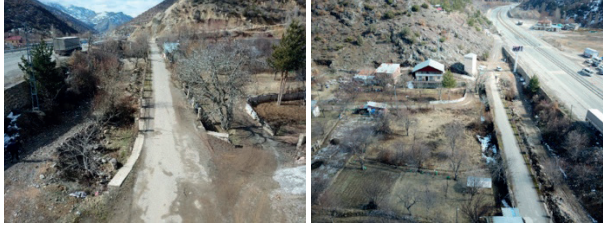
Şekil 10. Harava (İkisu) Köprüsü Betonarme Döşemesinin (Tabliyesinin) Doğudan-Batıya ve Batıdan-Doğuya Görünümü
