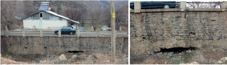
Şekil 24. Harava (İkisu) Köprüsü Mansap Cephesi, Üçüncü Kemerin Görünümü
