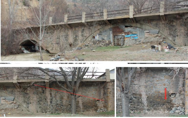
Şekil 23. Harava (İkisu) Köprüsü Mansap Cephesi, Küçük ve Büyük Kemerin Görünümü ve Tempan Duvarında Eğimli Tabliyeye İlişkin İzler
