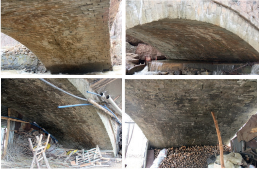
Şekil 40. Harava (İkisü) Köprüsü İlk/Küçük ve İkinci/Büyük Kemer Karın Taşlarından Görünümü
