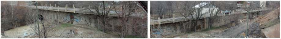
Şekil 19. Mansap Cephesi Batı Kısımındaki Özgün Kemer Gözlü Açıklıklar ve Doğusundaki Dönem Eki İlavesi
