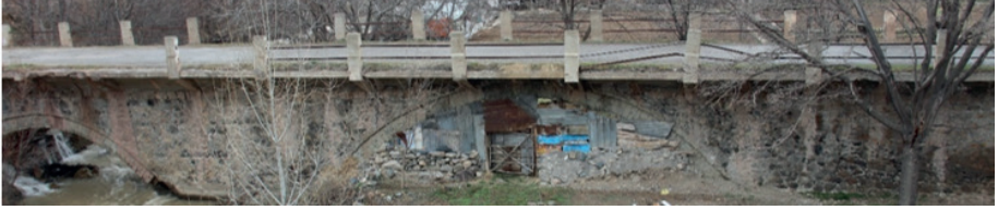
Şekil 8. Köprü'nün Beton Tablası ve Beton-L Profil Demir Profilli Korkuluklarına Mansap Cephesinden Bakış
