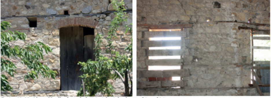
Resim 29-30. Ahşap Hatıllarda renk değişimi, kesit kaybı ve sehim etkisi
