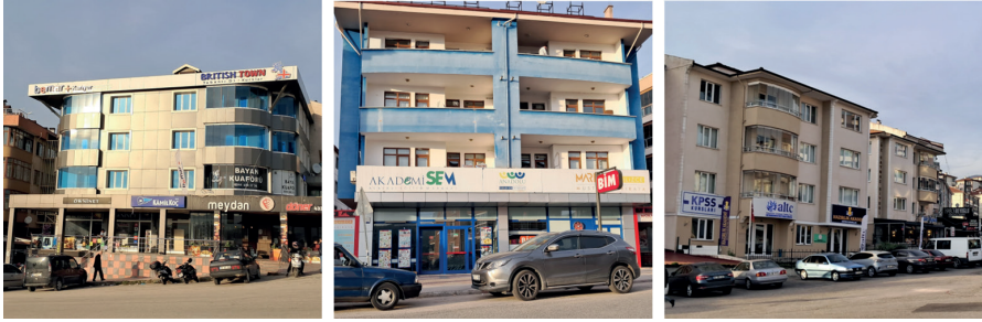
Şekil 6. 100. Yıl Mahallesi'nde Bulunan Çeşitli Kurslar.
