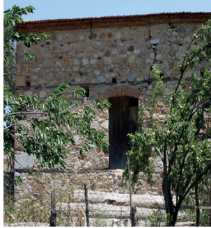
Resim 23-24-25. Dış cepheden okunan önemli strüktürel çatlaklar
