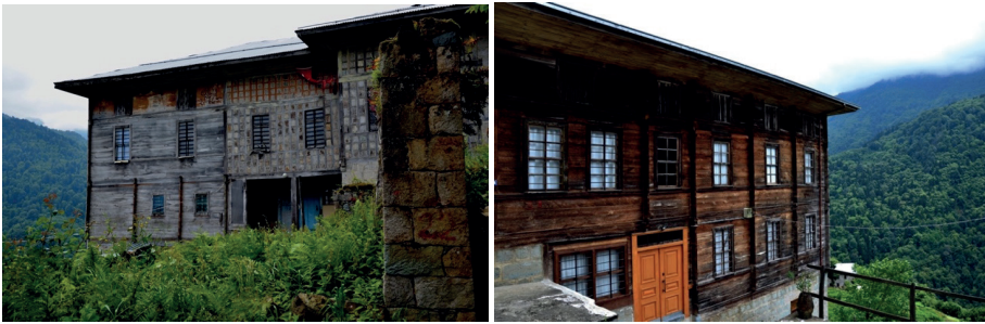
Şekil 5. Ahşap yığma ve ahşap karkas göz dolma, Küşüve Köyü Yukarı Mahalle (Yetim, 2017)
