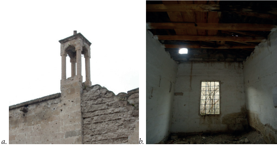
Şekil 19.a. Sandık duvarda dış kesme taş ve iç moloz taş şillez karışımı b. Hezenli tavan
