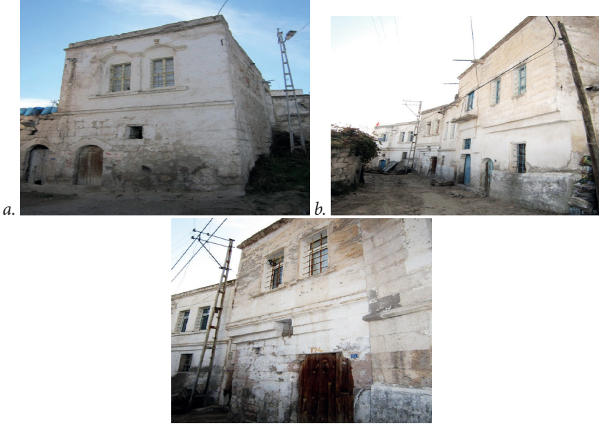
Şekil 18. A. Ahşap doğramalı demir parmaklıklı pencereler b. Işıklıklı çakma kapılar
