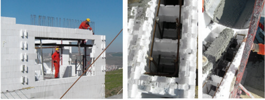
Resim 1. Sistemde Duvarların Oluşturulması (Özşahin, 2011)
