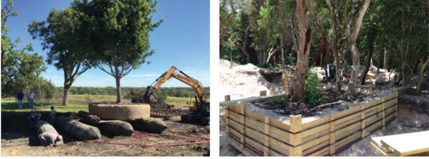
Şekil 4. Ağaç taşıma çalışmalarında kazı işlemleri, ağaçların sökülmesi ve köklerin korunması (balyalama ve kasalama) (Environmental Design Inc.,2022)
