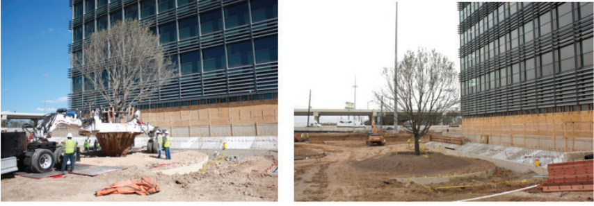
Şekil 7. Taşınan ağaçların, daha önceden hazırlanmış olan dikim çukurlarına yerleştirilmesi (Environmental Design Inc.,2022)
