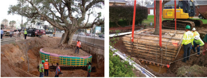
Şekil 10. Büyük boyutlu ağaçların naklinde kullanılan balyalama ve kasalama yöntemleri (Environmental Design Inc.,2022)
