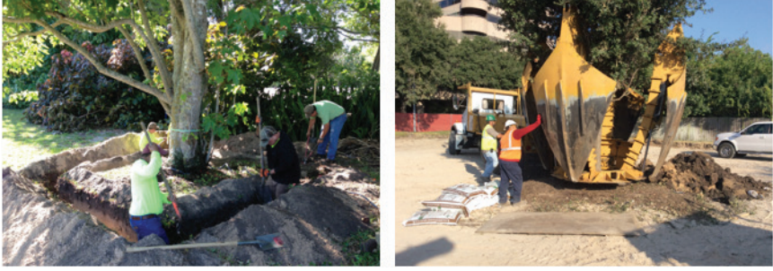
Şekil 3. Ağaç taşıma çalışmalarında kazı işlemleri, ağaçların sökülmesi ve köklerin korunması (insan gücü ve makine gücü) (Environmental Design Inc.,2022)
