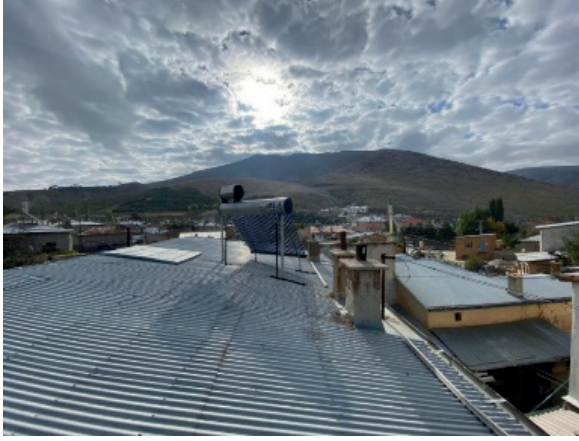
Resi13. Elif Ersak Evi Sonradan Eklenen Eğimli Çatı Görünüşü
