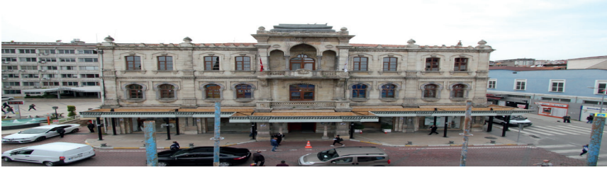
Şekil 8. Doğu Cephesindeki Yüzey Kirlenmeleri (Mostar-a, 2017)
