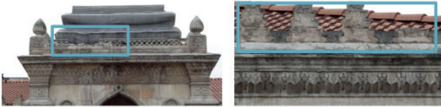
Şekil 9. Cephelerdeki Taş Kopmaları ve Aşınmaları (Mostar-a, 2017)
