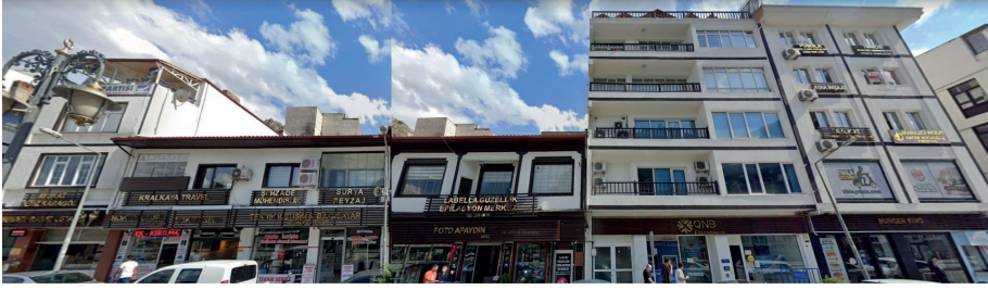
Şekil 3. Ada 2’de yer alan beş yapı
