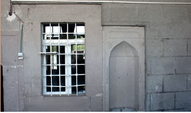
Şekil 15. Harimin son cemaat yerine bakan güney duvarı yüzeyinde ve mihrabiyelerin iç yüzeylerinde çimento malzemeden yapılmış taş desenli kabartmaların görünüşü
