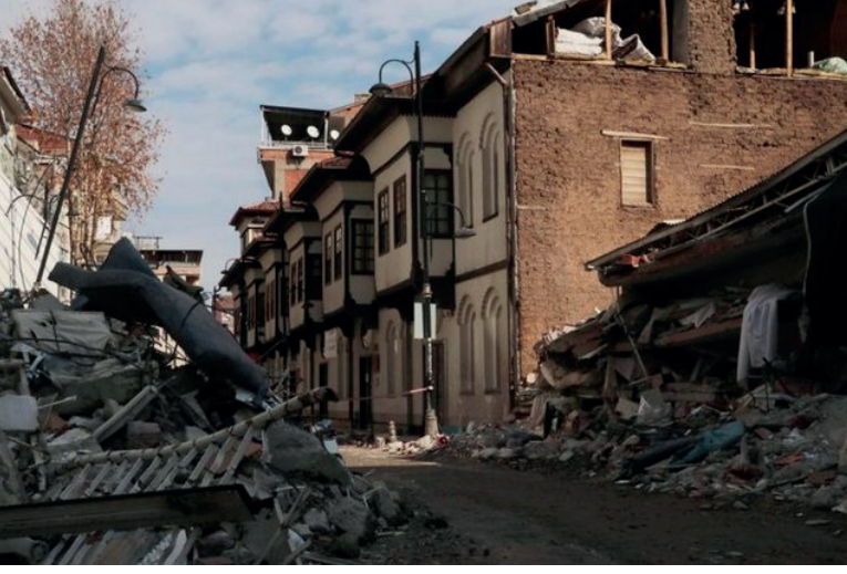
Görsel 3. Deprem sonrası Beşiktaş yapı grubu ve caddesi (Habertürk, 2023).
