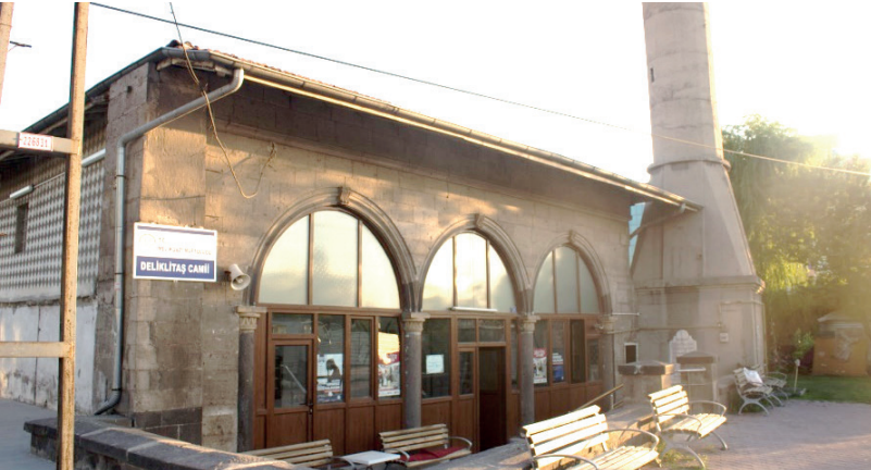
Şekil 16. Mescit son cemaat yerinin betonarme sütun, kemerler ve plastik malzemelerle kapatılan özgün olmayan ön yüzü
