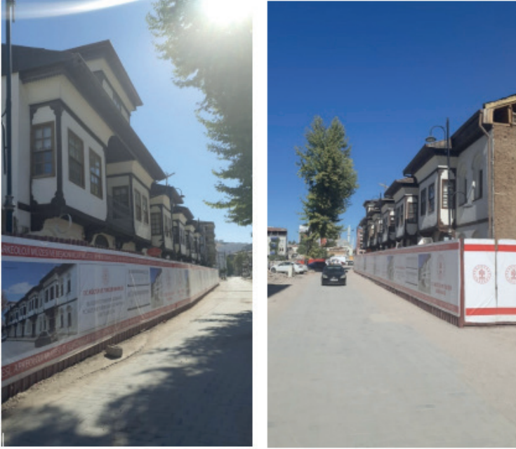
Görsel 5. Deprem sonrası temizlik çalışmalarının ardından Beşkonaklar yapı grubu ve caddesi (Alkan Korkmaz, 2023).
