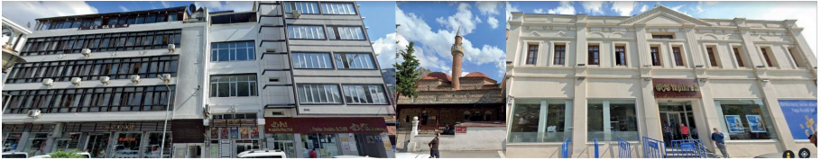
Şekil 4. Ada 3’te yer alan beş yapı
