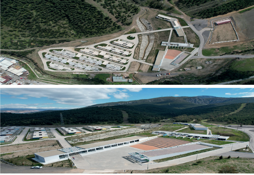
Şekil.6 Projenin uygulaması tamamlanan bölümlerine ilişkin hava fotoğrafı (Mert Uslu Mimarlık arşivi, 2023).
