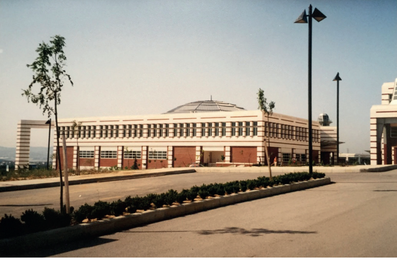
Resim 9. Sabancı Üniversitesi yapılardan görünüm. (Foto. A. C. Benli, 2001).
