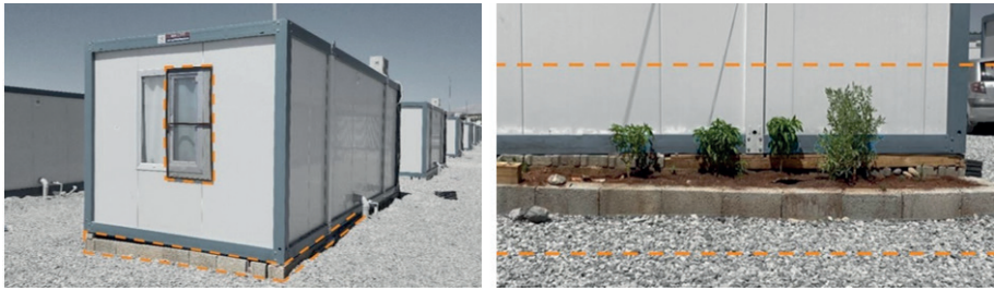
Şekil 5: Konteyner birimlerinde gözlemlenen tesviye problemleri ve probleme getirilen geçici çözüm önerileri.
