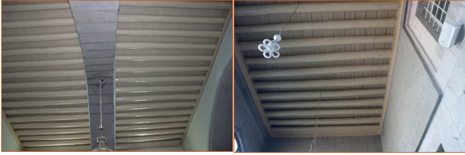
Şekil 10. Harim ve son cemaat yeri tavanında silindirik kesitli ahşap tomruk kirişlemelerin görünüşü
