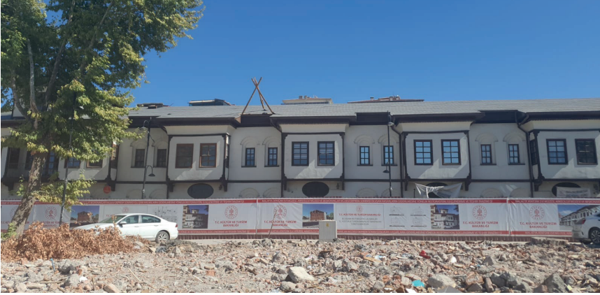
Görsel 2. Deprem sonrası temizlik çalışmalarının ardından Beşkonaklar yapı grubu. Caddenin karşısında yer alan yapı adasının tamamı yıkılmıştır (Alkan Korkmaz, 2023).
