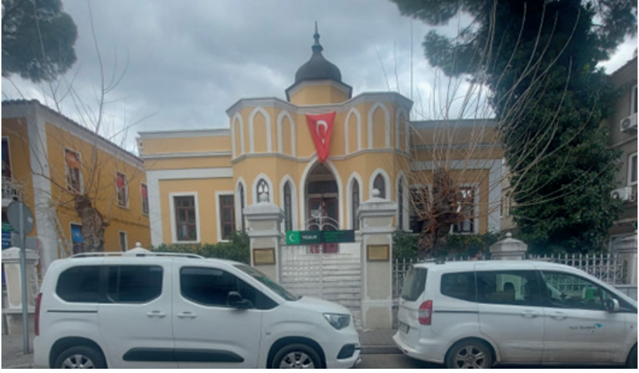
Resim 8: Güney (Ön) Cephesi (Foto. Dere, M.E.)
