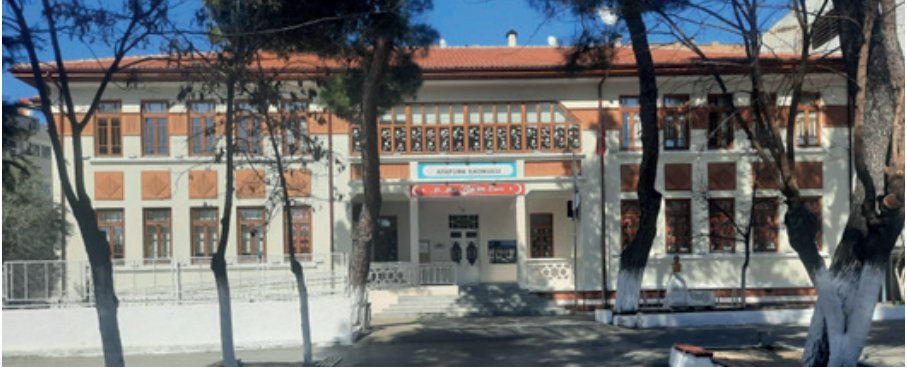
Resim 13: Güney (ön) Cephesi (Foto. Dere, M.E.)
