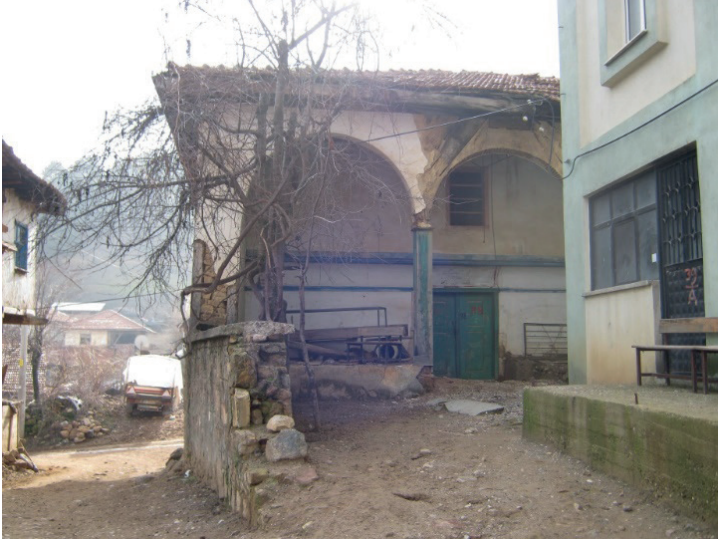
Resim 7. Yeşilyurt Köyü Camisi'nin son cemaat mahalline bakış ve yeni yapılan cami.
