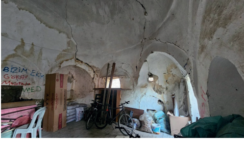
Resim 11: Sıbyan Mektebi İç Mekanında Kubbenin Güncel durumu, Resim 12: Sıbyan Mektebi devşirme malzemenin kullanımı ile üretilmiş payeler
