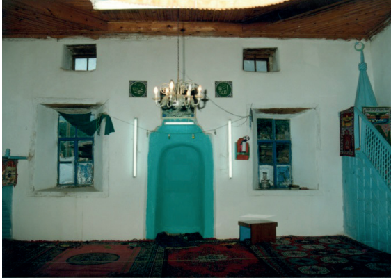
Resim 23. Kavacık Köyü Camisi iç mekanı. Kaynak: Kütahya Kültür Varlıklarını Koruma Bölge Kurulu Arşivi
