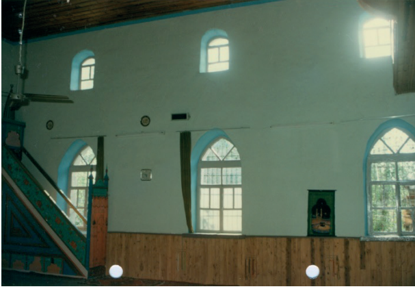
Resim 25. Çardaklı Camii beden duvarlarındaki tepe pencereleri. Kaynak: Kütahya Kültür Varlıklarını Koruma Bölge Kurulu Arşivi
