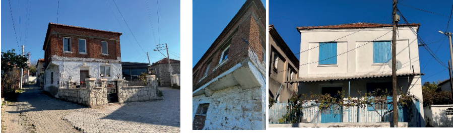
Resim 24-25-26-27: Cumhuriyet döneminde kentte betonarme destekli yığma yapıım sistemi ile üretilen konut mimarisi
