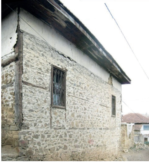
Resim 10. Caminin güneydoğu mihrap cephesi
