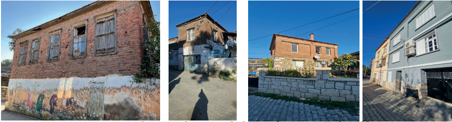
Resim 20-21-22-23: Cumhuriyet döneminde kentte betonarme destekli yığma yapım sistemi ile üretilen konut mimarisini
