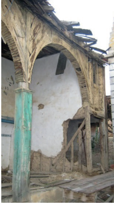
Resim 15. Yıkılan minare giriş kapısı.
