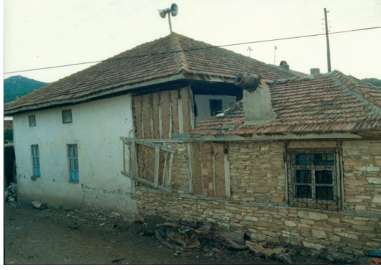
Resim 22. Kavacık Köyü Camisi. Kaynak: Kütahya Kültür Varlıklarını Koruma Bölge Kurulu Arşivi
