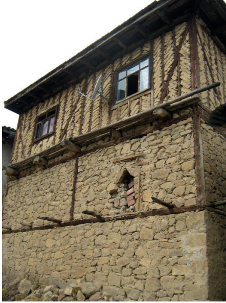
Resim 2. Yeşilyurt Köyü'nde moloz taş örgüsü ve hımış tekniği kullanılmış bir konut
