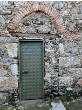
Resim9: Camiden Sıbyan Mektebine geçişi sağlayan sonradan küçültülen kapı açıklığı, Resim 10: Sıbyan Mektebi Giriş Cephesi
