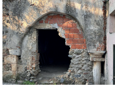
Resim 11: Sıbyan Mektebi İç Mekanında Kubbenin Güncel durumu, Resim 12: Sıbyan Mektebi devşirme malzemenin kullanımı ile üretilmiş payeler
