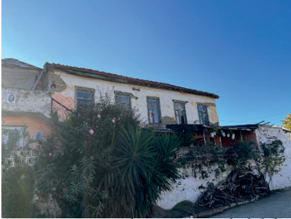
Resim:16 Kerpiç konut örneği, kübik biçimlenişli yapının saçağı ahşap malzemeden üretilmiştir. Pencerele dikdörtgen formludur ve etrafları ahşap söveler ile vurgulanmıştır. Resim:17 Kerpiç konut örneği, günümüzde pencereleri özgün boyutları korunarak doğramaları değiştirilmiştir geçmişte yapının merkezinde yer alan cumbasının özgün ferforje payandaları varlığını sürdürmektedir. Saçakları ahşaptan olup, oymalı ve bezemeli olarak özgünlüğünü korumaktadır.
