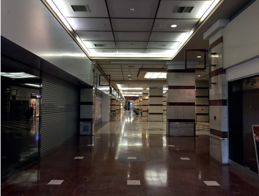
Şekil 12: Bodrum Katta Oluşan Karanlık ve Basık Mekânlar
