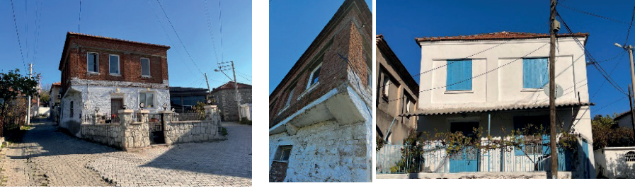
Resim 24-25-26-27: Cumhuriyet döneminde kentte betonarme destekli yığma yapıım sistemi ile üretilen konut mimarisi
