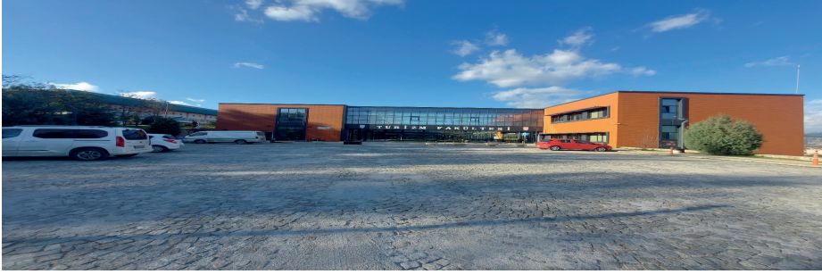
Resim 9: Güney Cephesi (Foto: Dere, M. E.)
