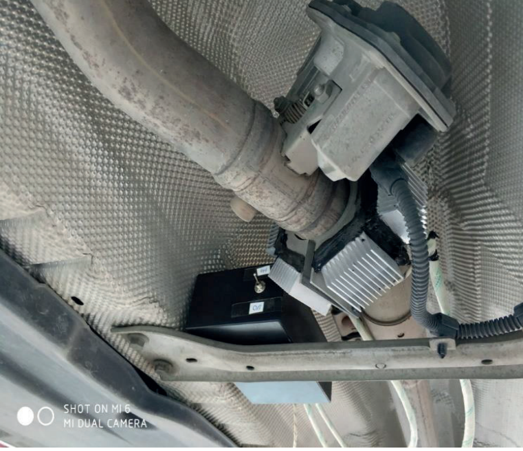
Şekil 7: Termoelektrik modül ünitesinin egzoz sistemine montajı[7].
