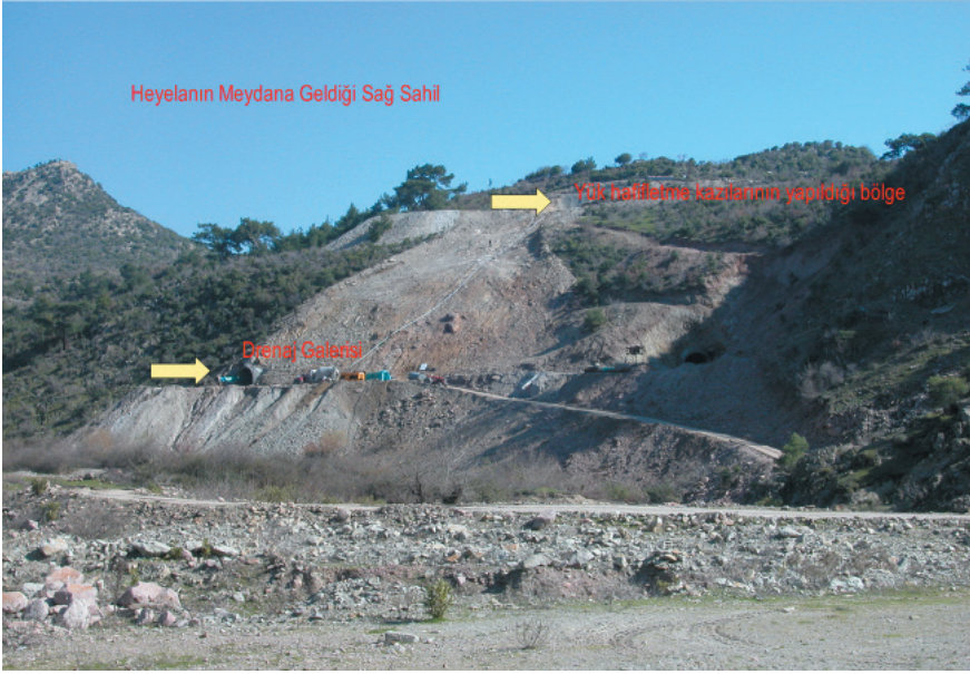
Şekil 1. Çaltıkuru barajı sağ sahil heyelan bölgesi.
