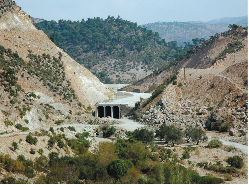
Şekil 3. Heyelan bölgesinden taşkın sularını geçirecek konduvi inşaatı.
