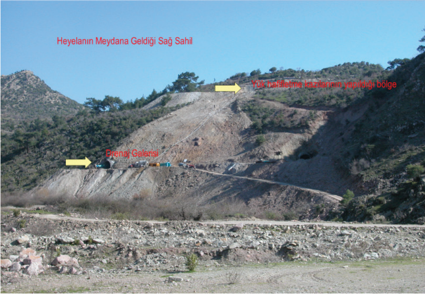
Şekil 1. Çaltıköy barajı sağ sahil heyelan bölgesi.
