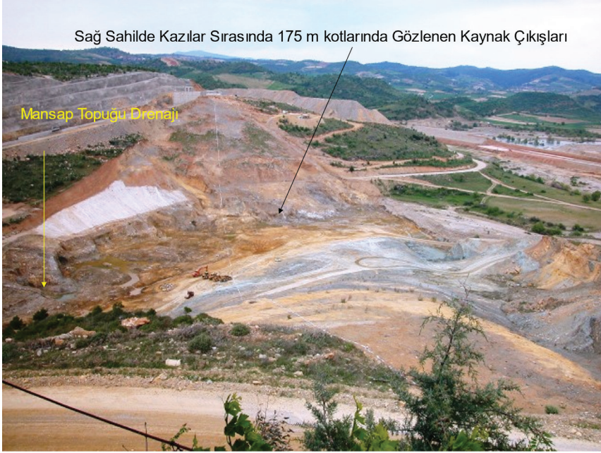
Şekil 9. Gördes barajı gövde dolgusu civarında gözlemlenen kaynak çıkışları (DSİ, 2010).
