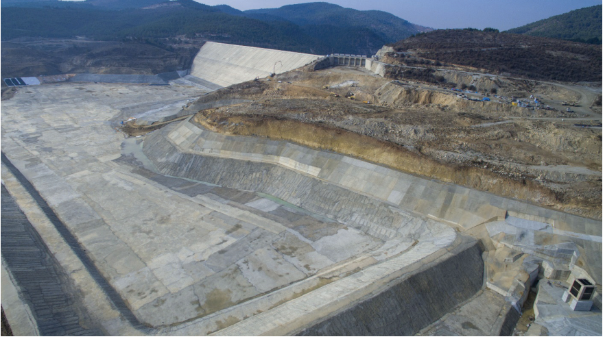
Şekil 12. Gördes barajı göl alanının beton ve geomembran ile kaplanması (URL-4).
