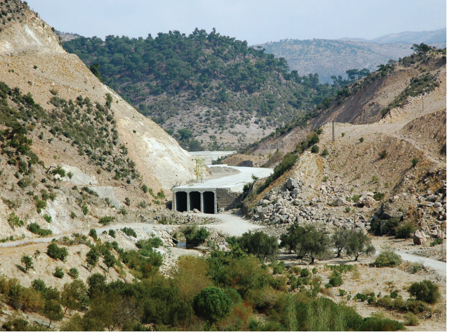
Şekil 3. Heyelan bölgesinden taşkın sularını geçirecek konduvi inşaatı.
