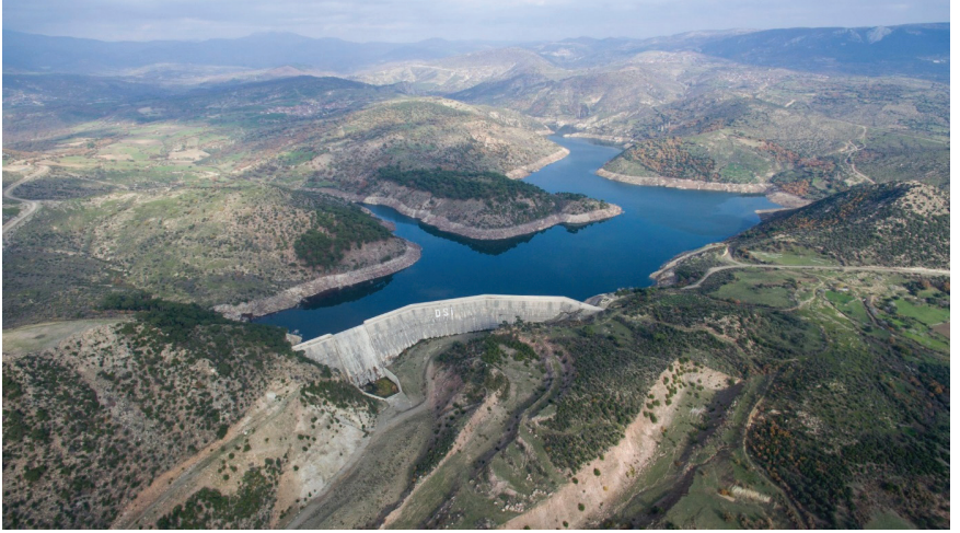
Şekil 4. Çaltıkoru Barajının tamamlanmış hali.
