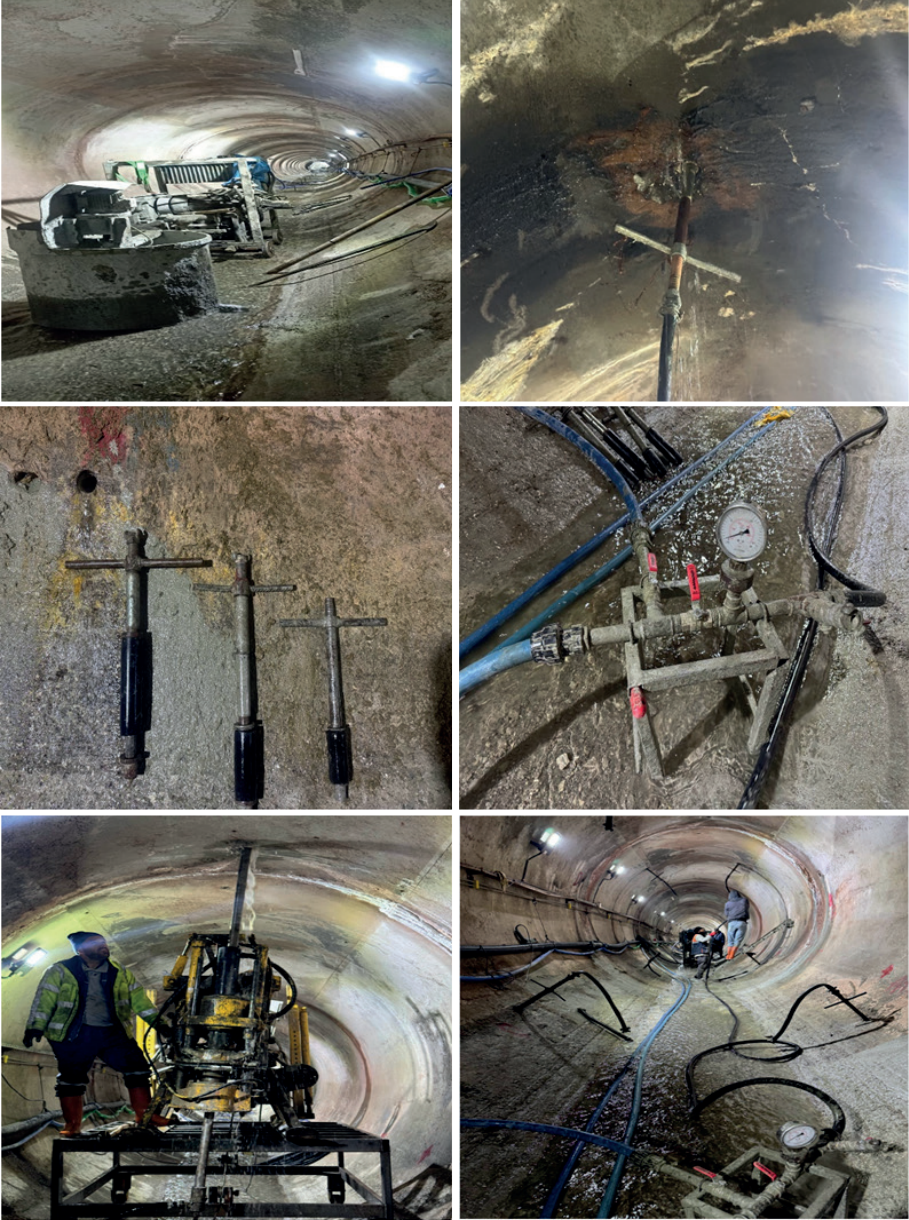
Şekil 4.2 Derivasyon tüneli delgi ve enjeksiyon hazırlık çalışmaları (Morgedik Barajı).
