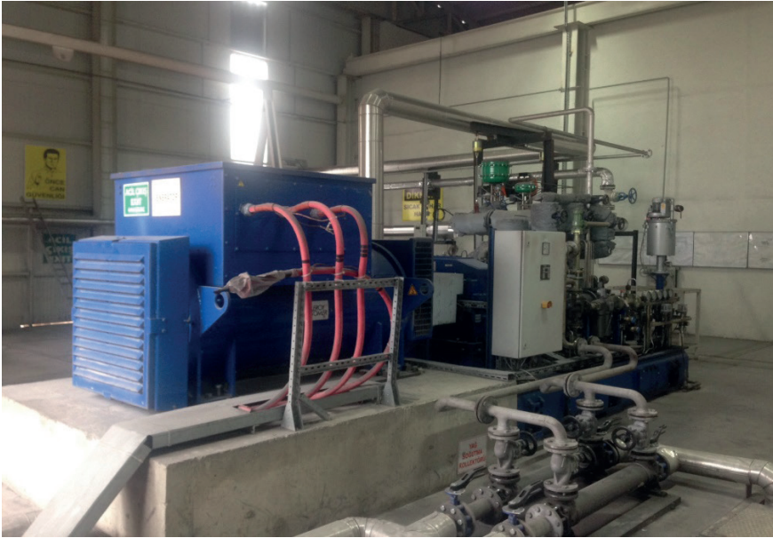
Şekil 2. Buhar Türbini Ekipmanları
