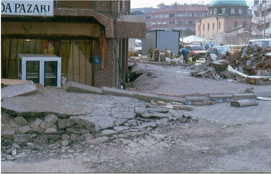
Şekil 1. 1999 Türkiye Adapazarı ilinde meydana gelen depremin neden olduğu sıvılaşmanın etkileri ( http://www.jeofizik.org.tr/resimler/ekler/d50601b7bc18501_ek.pdf )
