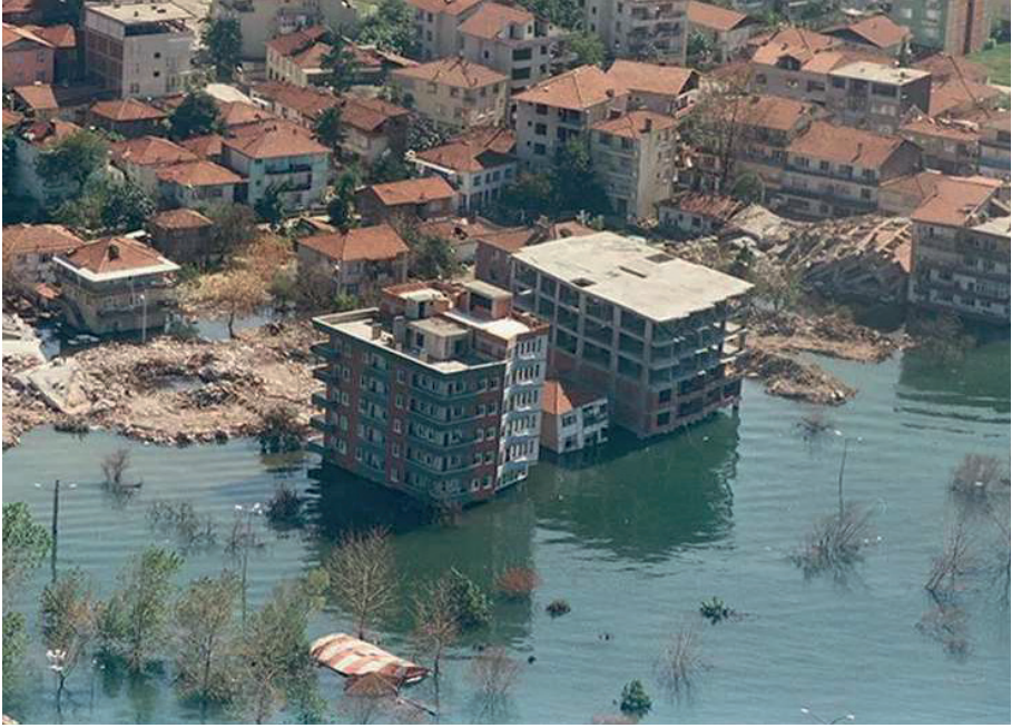
Şekil 12. Kocaeli depremi sonrası yanal yayılmaya bağlı sivilaşma görüntüleri
