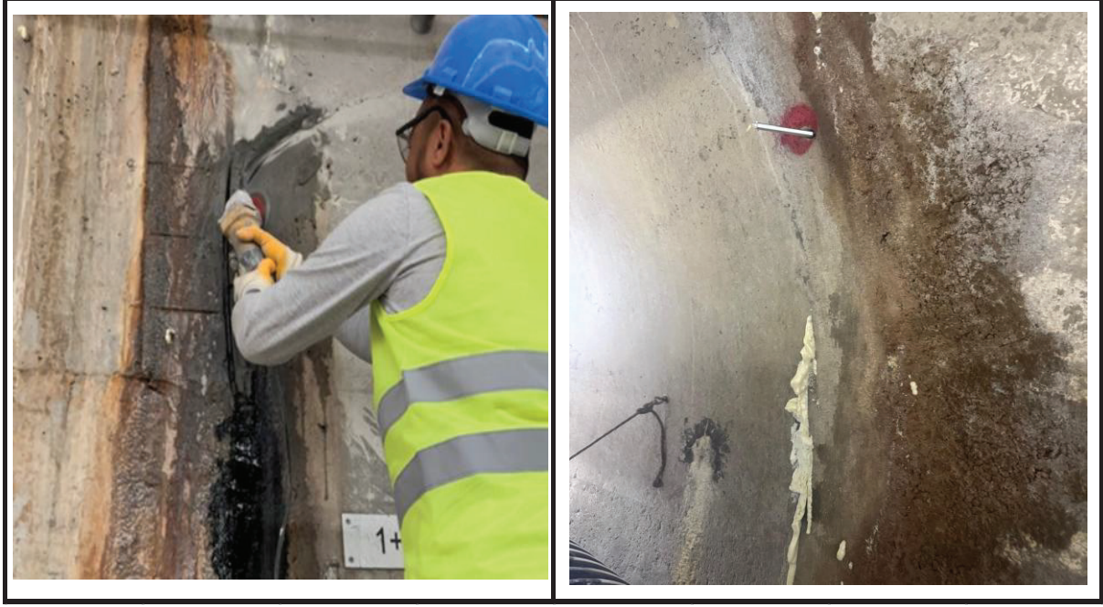
Şekil 3. Kimyasal enjeksiyonda çatlak temizliği ve paker bağlama çalışması.
