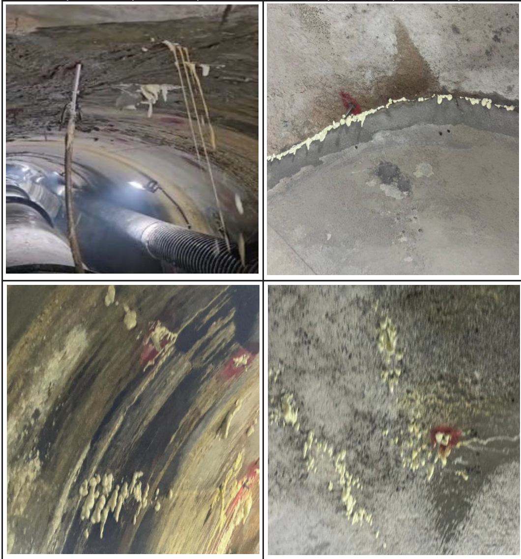
Şekil 6. Poliüretan reçinenin enjeksiyon uygulama kesitleri (Morgedik Barajı Derivasyon Tüneli).
