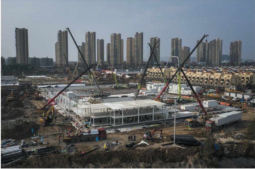
Şekil 6. İnşa edilen iki yeni hastaneden biri olan 25.000 metrekareslik Huoshenshan Hastanesi inşa aşaması (2020, BBC).
