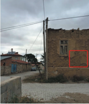
Cephelerin kerpiç sıva ile onarılması
