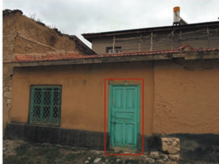
Pencere ve kapı doğramalarının ahşap malzeme ile yenilenmesi
