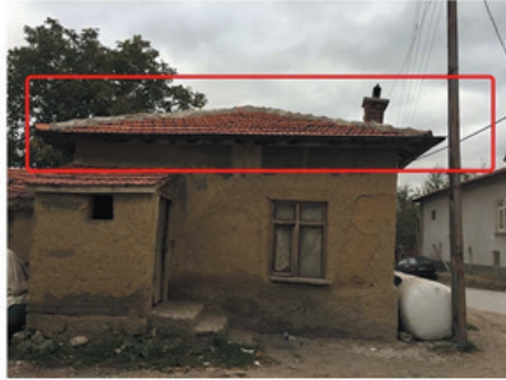
Çatıların alaturka tipi kiremit ile onarılması
