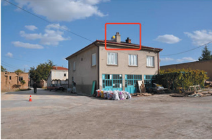
Bacaların onarılması ve temizlenmesi
