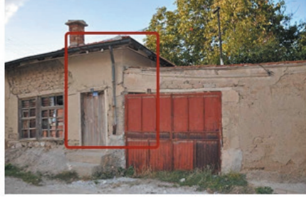
Yağmur oluklarının yenilenmesi
