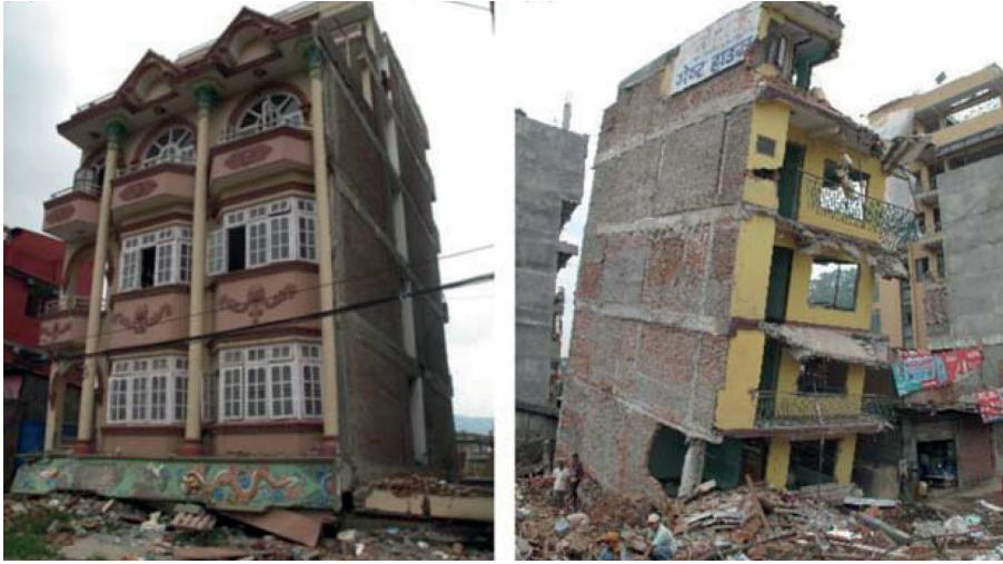
Şekil 1. Yumuşak kat düzensizliğinin yapısal etkisi (Varum ve diğerleri, 2018:51).
