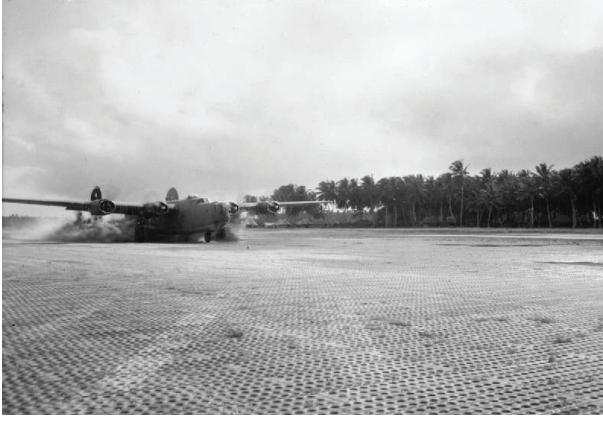
Şekil 1. Delikli çelik plaklardan imal edilmiş geçici pist ve iniş-kalkış alanı.
