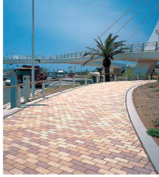
Şekil 1. Japonya'da kullanılan fotokatalitik, kendini temizleyen yol döşemesi [9].
