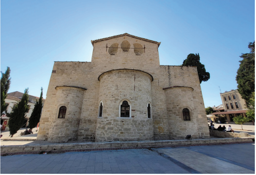
Fotoğraf 8: Doğu cephenin görünümü. (Kaynak: Yazar tarafından çekilmiştir)
