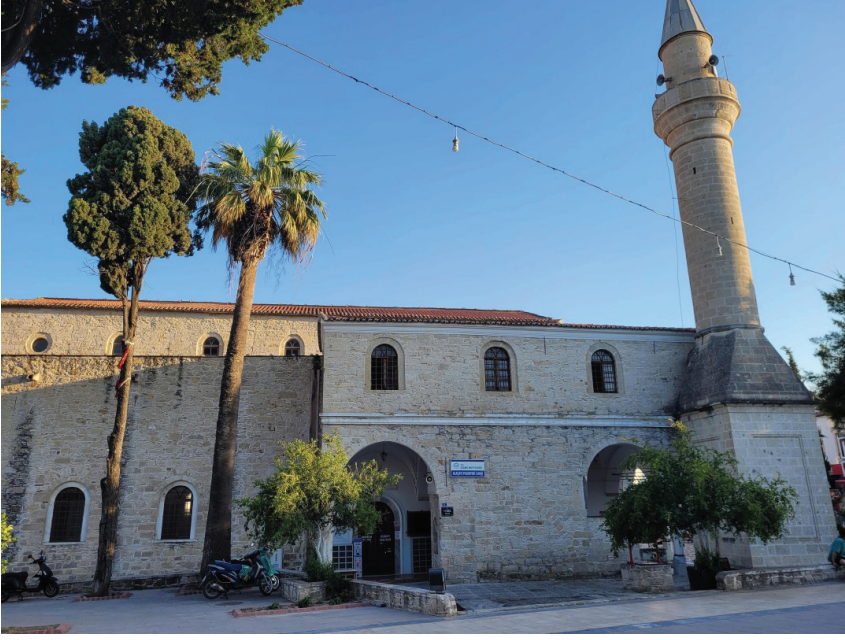
Fotoğraf 4: Kuzey cephenin görünümü. (Kaynak: Yazar tarafından çekilmiştir)
