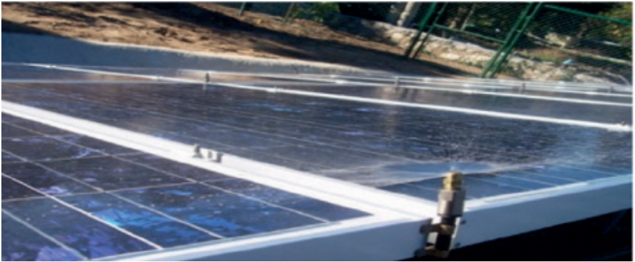
Şekil 9. Yüksek Basınçlı Su Jeti (Derakhshandeh ve ark. 2021).
