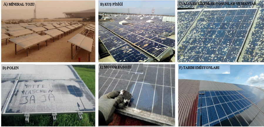
Şekil 2. Güneş panelleri üzerindeki farklı kirlenme türleri (Ilse ve ark. 2019).
