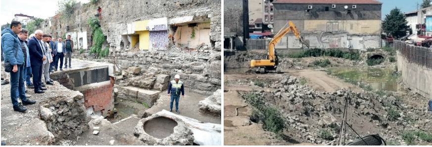
Şekil 25. İnşaat Sırasında Çıkan Tarihi Yapılar
