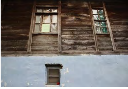
Görsel 4.250. Alan Köyü Veysel Bircan Evi batı cephesi
