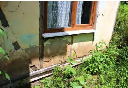
Görsel 4.320. Karacaören Köyü Ali Tokatlıođlu Evi ahşap karkas duvar
