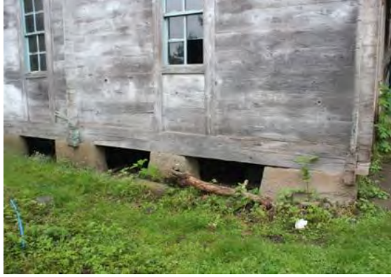
Görsel 4.11. Alan Köyü Camii taş temel
