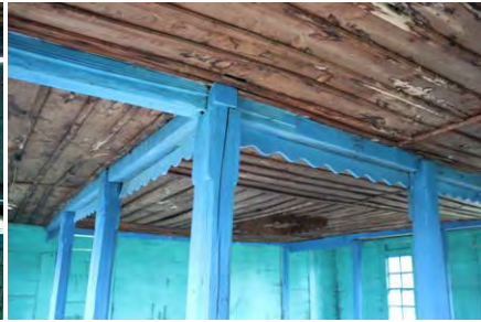
Görsel 4.81. Karaman Ahşap Camii mahfil katı direkleri
