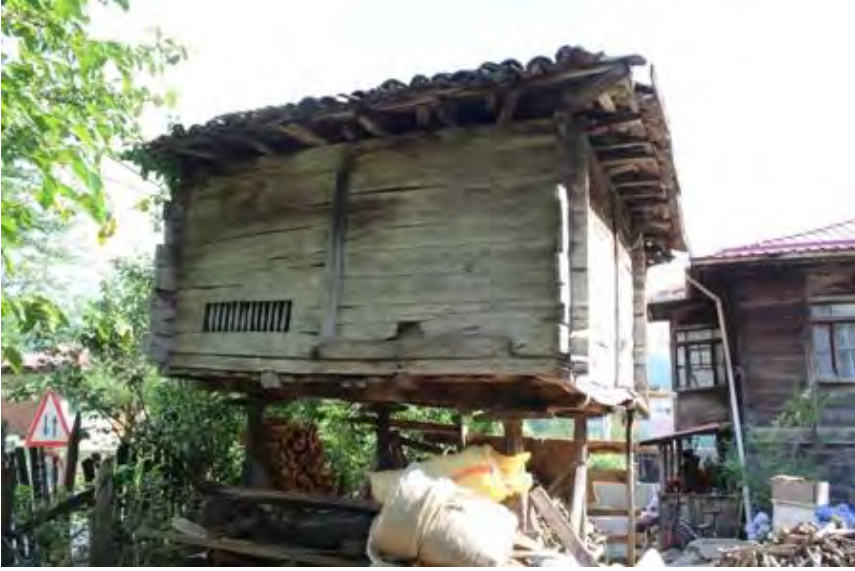
Görsel 4.409. Alan Köyü Mehmet Şensoy Sereni kuzey cephesi
