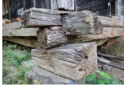
Görsel 4.90. Karaman Düz Kırık Mevkii Mescidi kuzeydoğu köşe taban kirişi ve taş temel
