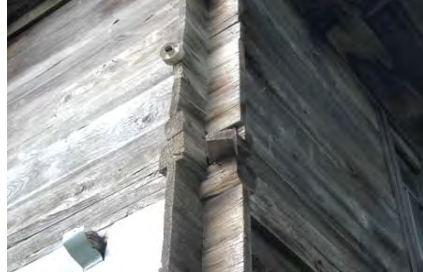
Görsel 4.53. Karacaören Köyü Soyuk Mahallesi Camii kurt boğazı geçmeler ve kat girişleri
