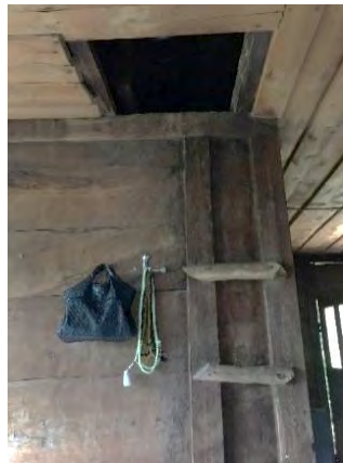
Görsel 4.299. Karacaören Köyü Muammer Çakır Evi çatıya çıkış merdiveni
