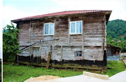
Görsel 4.382. Karaman Köyü Yusuf Keleş Evi kuzey cephesi
