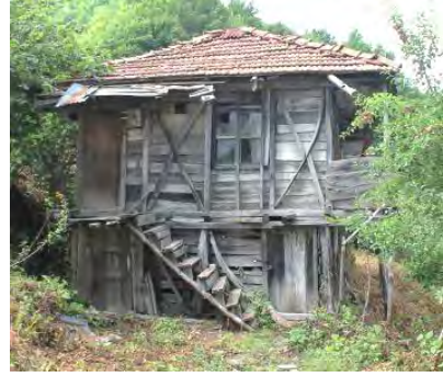
Görsel 5.148. Salıpazarı Cevizli Köyü yakınlarından tahta kaplamalı ahşap karkas duvarlı ev örneği
