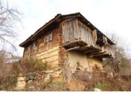
Görsel 5.181. Samsun Tekkeköy Çayırçökek Köyü'nden ıslak mekân çıkmalı ev örneği (M. Sami Bayraktar Arşivi)
