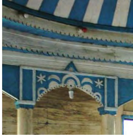
Görsel 5.250. Alan Köyü Camii mahfil katı direkler arasında yer alan ahşap kemer
