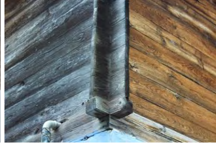
Görsel 4.251. Alan Köyü Veysel Bircan Evi kat kirişi ve kurt boğazı geçmeler
