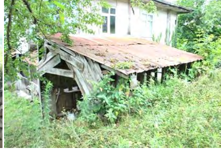
Görsel 4.709. Alan Köyü Muhittin Şensoy Garajı çatısı
