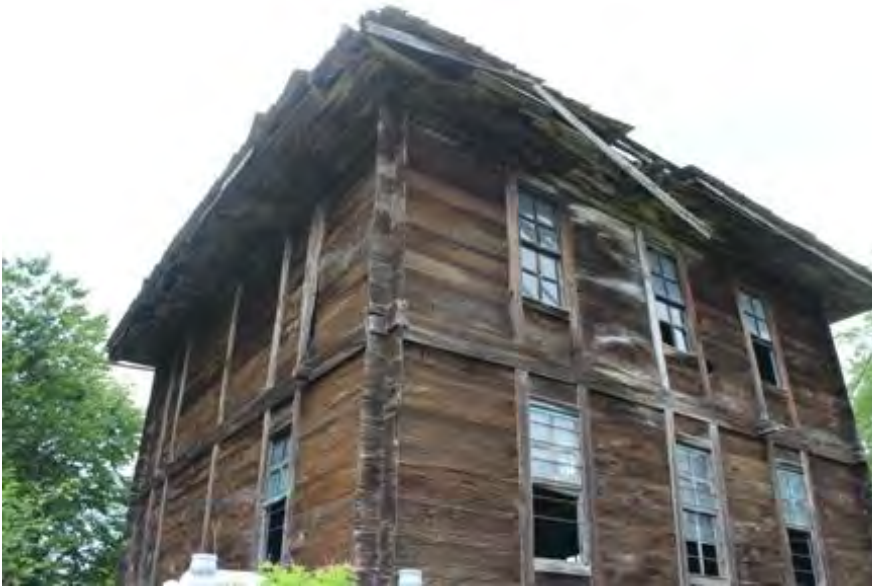
Görsel 4.73. Karaman Ahşap Camii güney ve doğu cepheler
