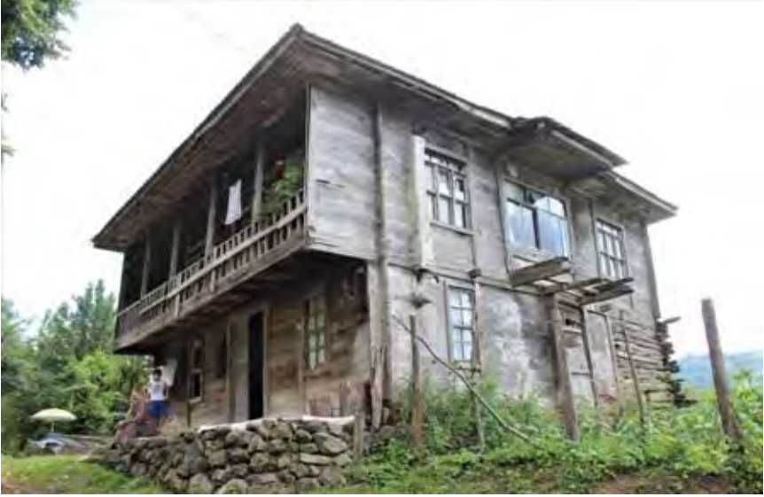
Görsel 4.291. Karacaören Köyü Muhammer Çakır Evi doğu ve kuzey cephesi
