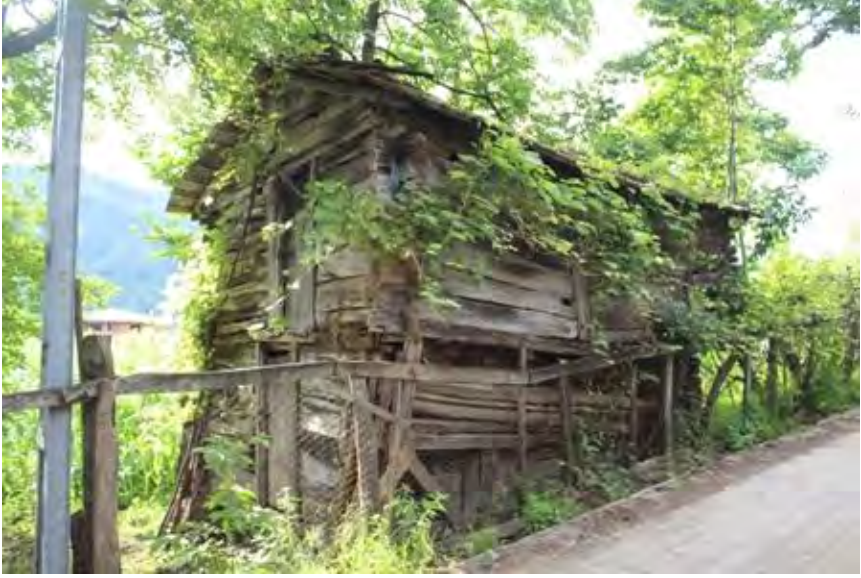
Görsel 4.692. Karacaören Köyü Duran Tekin Samanlığı doğu cephesi
