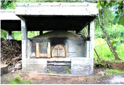
Görsel 4.656. Karacaören Köyü Muhammer Çakır Fırını ön cephe
