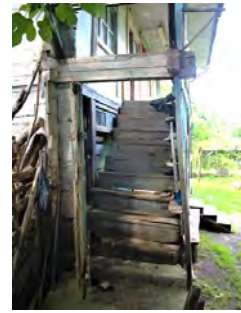
Görsel 5.170. Karacaören Köyü Mustafa Tokatlıoğlu Evi 1. kattaki balkona çıkılan tek yönlü merdiven
