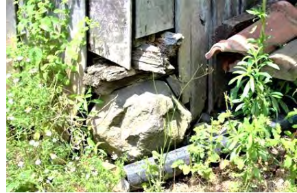
Görsel 4.593. Alan Köyü Mehmet Bircan Fırını kuruluşunun taş temel ve ahşap kiriş ayrıntısı
