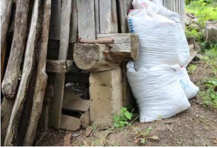
Görsel 4.480. Alan Köyü Sabahattin Somuncu Sereni taş temel ayrıntısı (beton ile değiştirilmiş)
