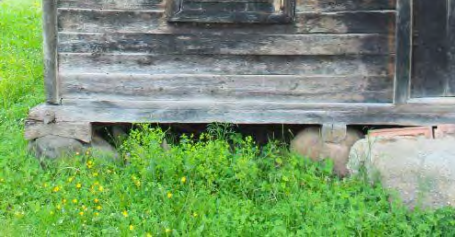
Görsel 5.140. Salıpaazarı Düzköy'de yer alan bir evin tekil (münferit) temel taşları
