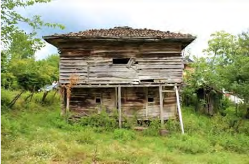
Görsel 4.160. Alan Köyü Yusuf Zengin Evi batı cephesi
