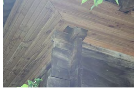
Görsel 4.331. Karacaören Köyü Selahattin Cebebi Evi çatı saçağı
