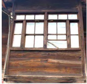
Görsel 5.164. Alan Köyü Mehmet Şensoy Evi iki yanda sabit cam ortada giyotin pencere örneği
