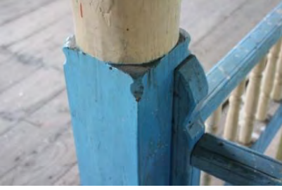
Görsel 4.38. Alan Köyü Camii mahfil katı ağşap direk altlık ayrıntısı
