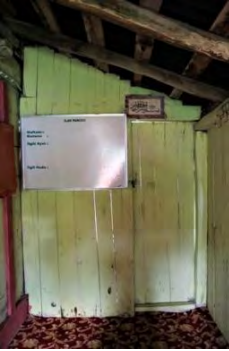
Görsel 4.54. Karacaören Köyü Soyuk Mahallesi Camii son cemaat mahalli köşesinde yer alan odanın kapısı
