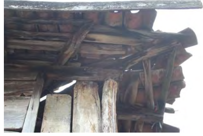
Görsel 4.415. Alan Köyü Mehmet Şensoy Sereni çatı saçağı
