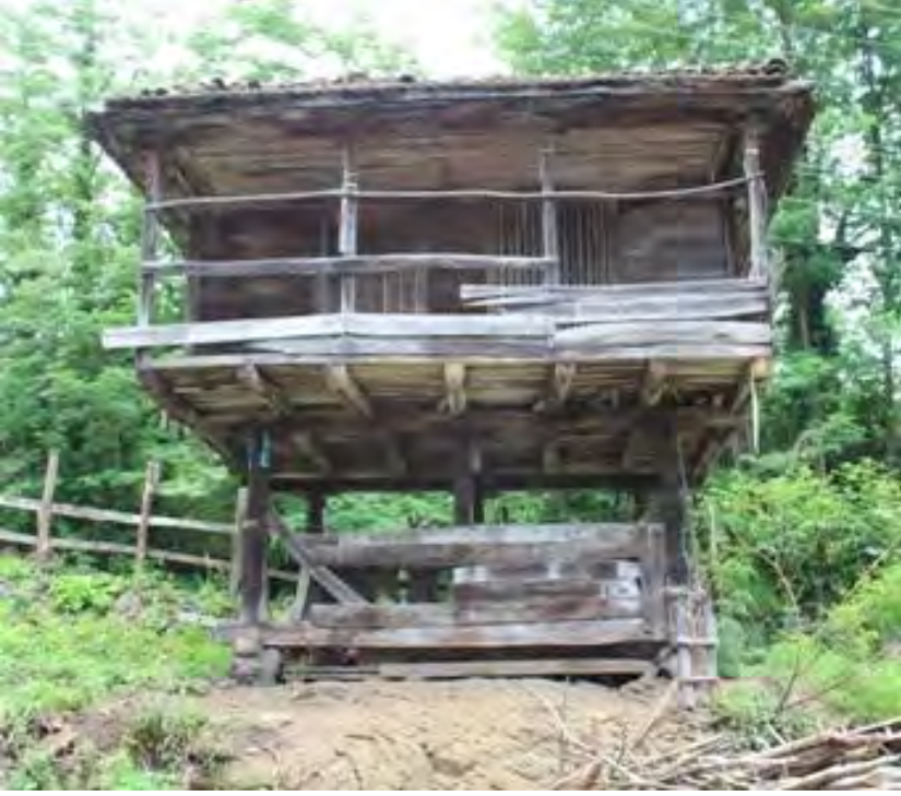
Görsel 4.419. Alan Köyü Cemal Bal Sereni ön cephesi
