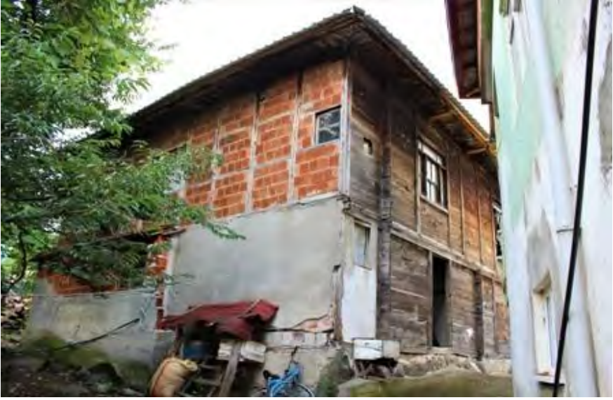
Görsel 4.215. Alan Köyü Mehmet Şensoy Evi güney cephesi
