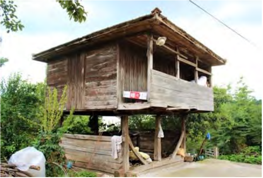
Görsel 4.430. Alan Köyü Celalettin Somuncu Sereni doğu ve kuzey cephesi
