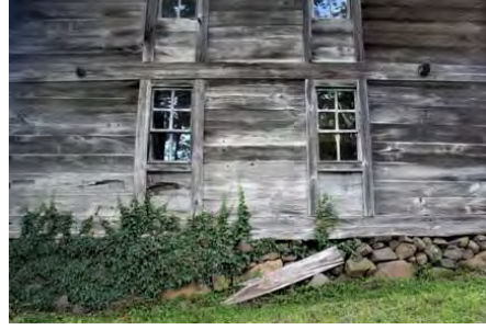
Görsel 4.51. Karacaören Köyü Soyuk Mahallesi Camii güney cephesi temel taşları
