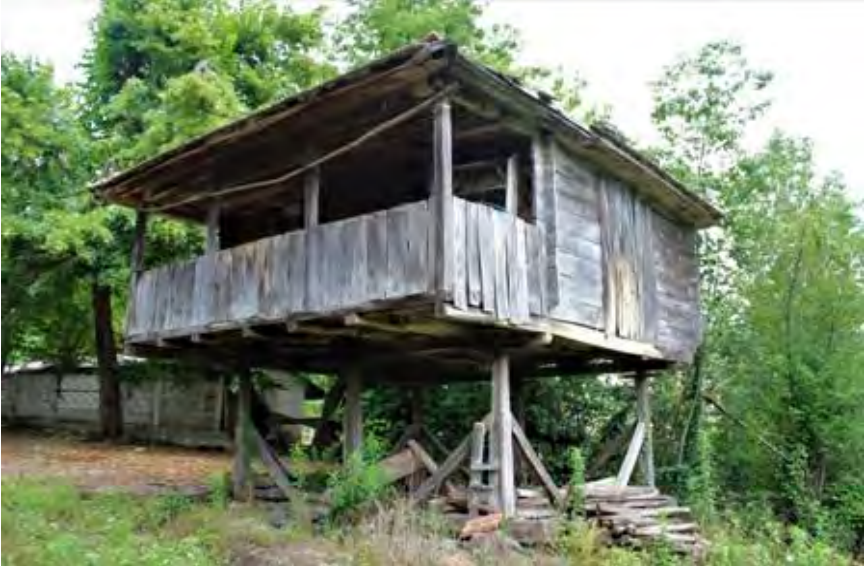
Görsel 4.395. Alan Köyü İsa Zengin Sereni doğu ve güney cephesi
