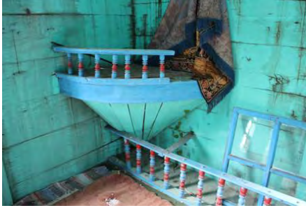
Görsel 4.78. Karaman Ahşap Camii vaaz kürsüsü
