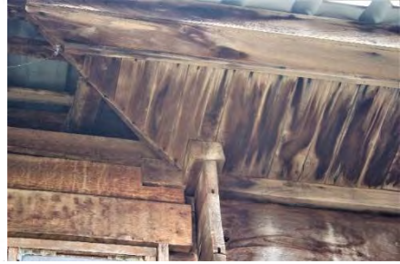
Görsel 4.374. Karaman Köyü Cemal Keleş Evi çatı saçağı (kaplamalı)
