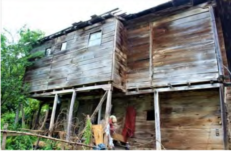
Görsel 4.204. Alan Köyü Kemal Gür Evi doğu cephesi
