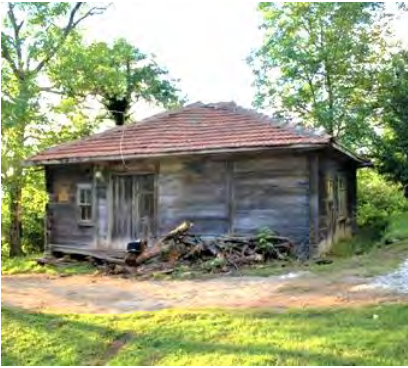
Görsel 4.100. Karacaören Soyuk Mahallesi İlkokulu ön cephe
