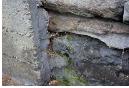
Görsel 4.659. Karacaören Köyü Muhammer Çakır Fırını ön cephe detay
