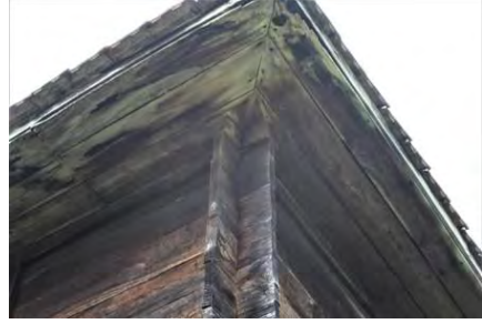
Görsel 4.519. Alan Köyü Muhittin Şensoy Sereni çatı saçağı
