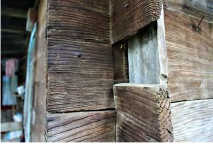
Görsel 4.353. Karaman Köyü Rabie Yıldız Evi güneydoğu köşe kurt boğazı geçmeler
