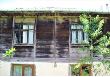
Görsel 4.318. Karacaören Köyü Ali Tokatlıođlu Evi dođu cephesi
