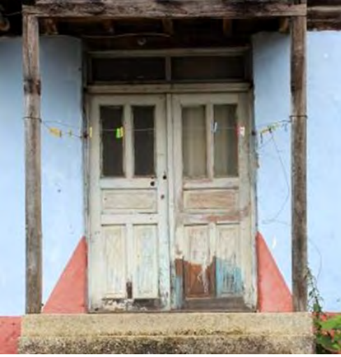
Görsel 5.161. Alan Köyü Veysel Bircan Evi doğu cephesindeki tablalı giriş kapısı
