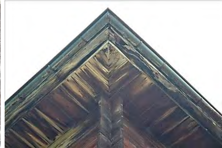
Görsel 4.255. Alan Köyü Veysel Bircan Evi çatı saçağı
