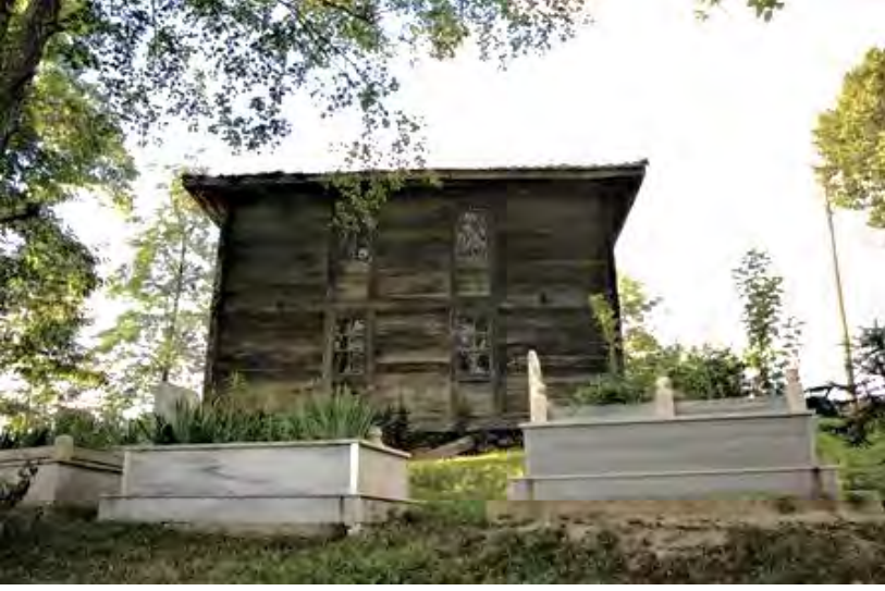
Görse 4.48. Karacaören Köyü Soyuk Mahallesi Camii güney cephesi
