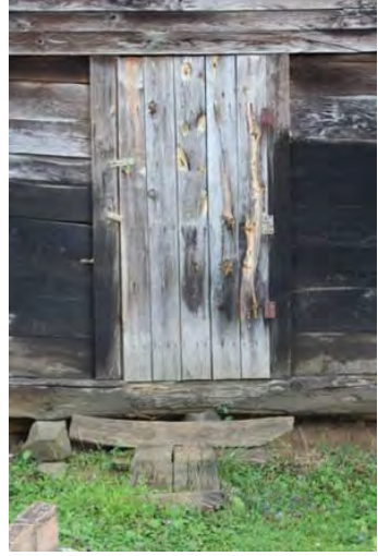
Görsel 5.162. Karaman Köyü Yusuf Keleş Evi tek kanatlı ve çakma usullü ahır kapısı
