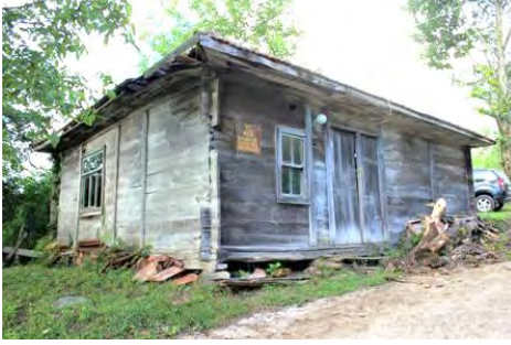
Görsel 4.102. Karacaören Soyuk Mahallesi İlkokulu batı ve güney cepheler
