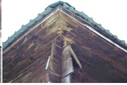
Görsel 4.384. Karaman Köyü Yusuf Keleş Evi çatı saçağı
