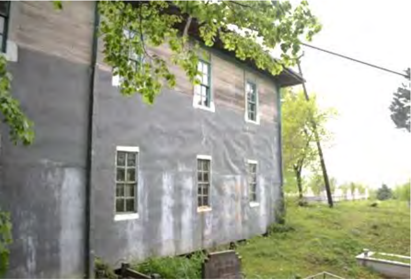
Görsel 4.9. Alan Köyü Camii batı cephesi
