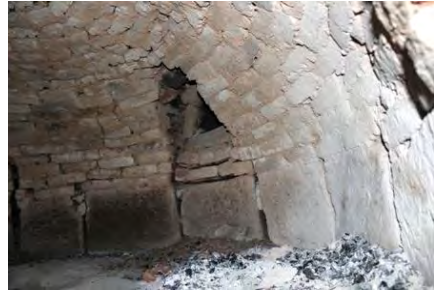
Görsel 4.635. Alan Köyü Muhittin Şensoy Fırını pişirme hücresi bacası ağız ve kubbe ayrıntısı
