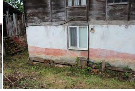
Görsel 4.239. Alan Köyü Resul Zengin Evi batı cephesi
