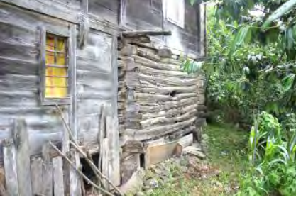
Görsel 5.144. Salıpazarı Cevizli Köyü'nden ahşap yığma duvarlı ev örneği
