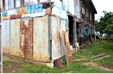
Görsel 4.380. Karaman Köyü Yusuf Keleş Evi ön cephesi alt kat
