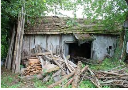
Görsel 4.746. Alan Köyü Hikmet Sağlam Atölyesi ön cephe
