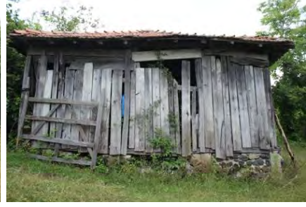
Görsel 4.639. Alan Köyü Muhittin Şensoy Fırını güney cephe
