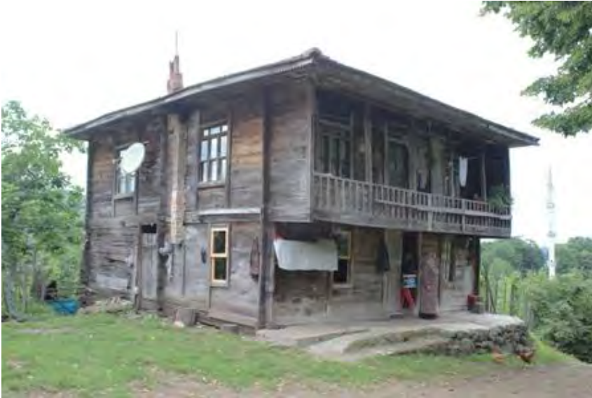
4.300. Karacaören Köyü Muhammer Çakır Evi güney ve doğu cephesi
