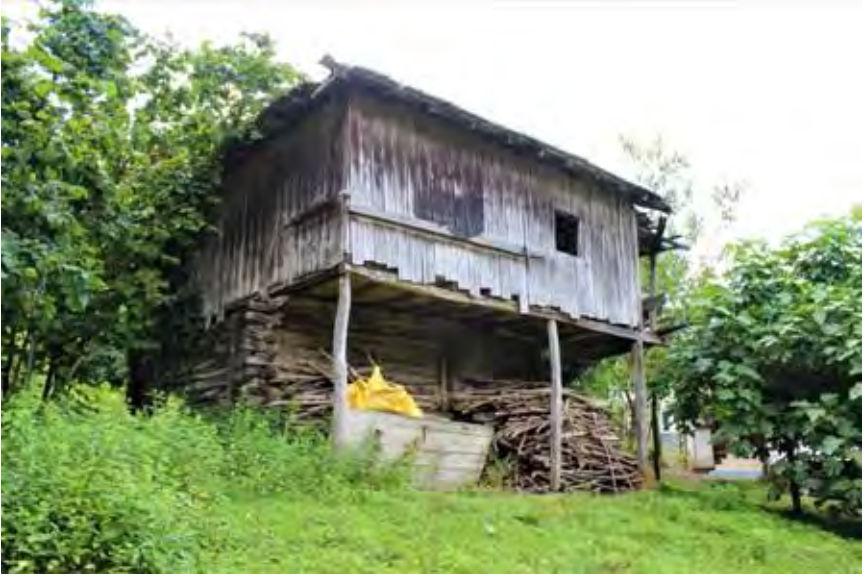
Görsel 4.680. Karacaören Köyü İlyas Keskin Samanlığı güney ve doğu cephesi
