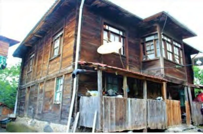
Görsel 4.213. Alan Köyü Mehmet Şensoy Evi güney ve doğu cephesi
