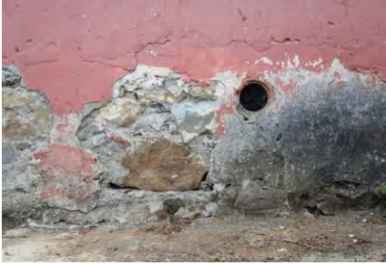
Görsel 4.252. Alan Köyü Veysel Bircan Evi doğu cephesi taş temel ve havalandırma deliği
