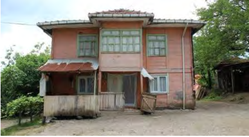
Görsel 4.181. Alan Köyü Sabahattin Somuncu Evi ön cephesi
