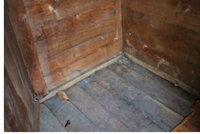
Görsel 4.144. Alan Köyü Muhittin Şensoy Evi 1. kat oda döşemesi
