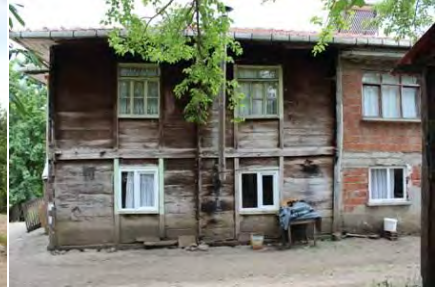
Görsel 4.183. Alan Köyü Sabahattin Somuncu Evi kuzey cephesi
