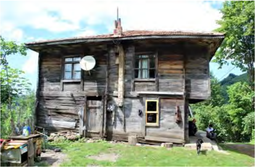
Görsel 4.292. Karacaören Köyü Muhammer Çakır Evi güney cephesi
