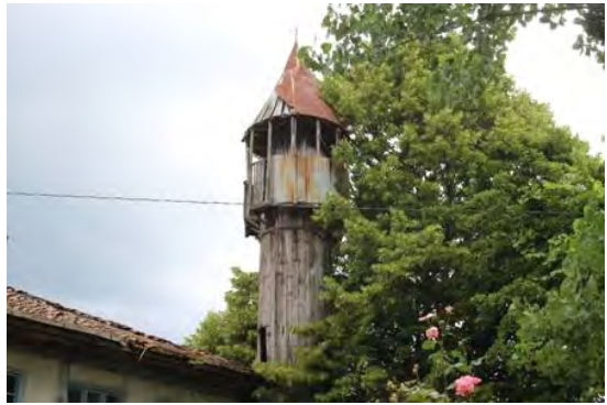
Görsel 4.15. Alan Köyü Camii minaresi
