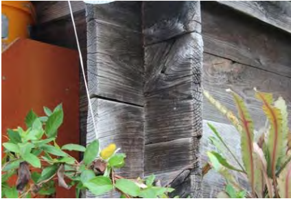
Görsel 4.308. Karacaören Köyü İbrahim Tekin Evi güneydoğu köşe kurt boğazı geçmeleri
