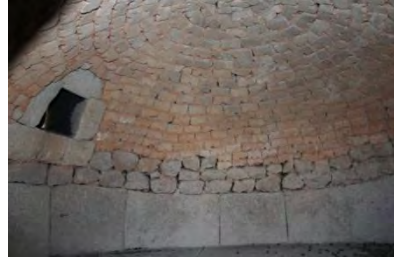
Görsel 4.589. Alan Köyü Mehmet Bircan Fırını pişirme hücresi içi (solda baca ağzı)
