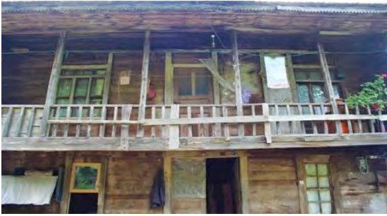
Görsel 4.296. Karacaören Köyü Muammer Çakır Evi ön cephesi
