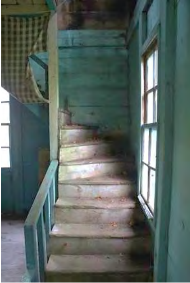
Görsel 4.34. Alan Köyü Camii batı yönündeki merdiven
