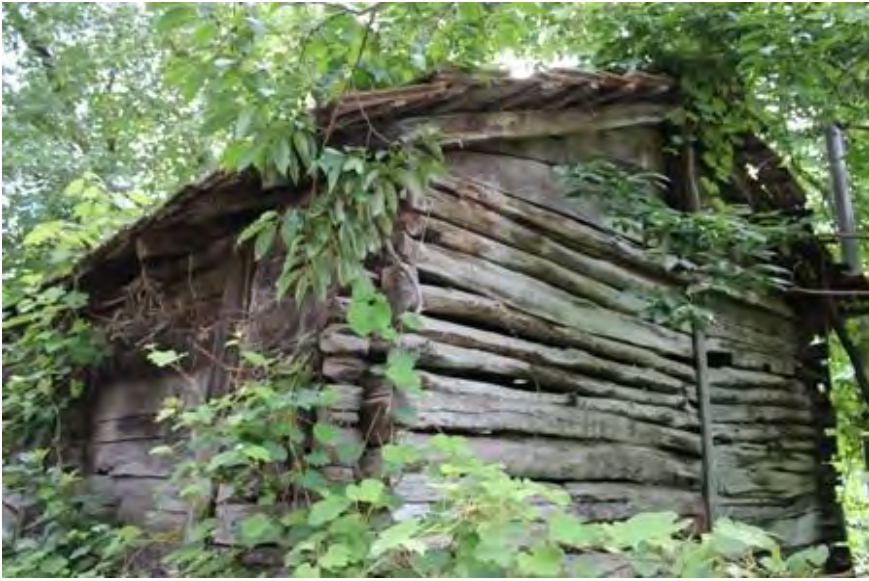
Görsel 4.693. Karacaören Köyü Duran Tekin Samanlığı doğu ve kuzey cephesi
