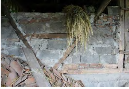
Görsel 4.632. Alan Köyü Muhittin Şensoy Fırını güney cephe
