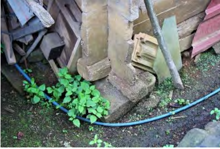
Görsel 4.371. Karaman Köyü Cemal Keleş Evi taş temel ve taban kirişi
