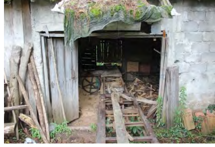
Görsel 4.747. Alan Köyü Hikmet Sağlam Atölyesi girişi
