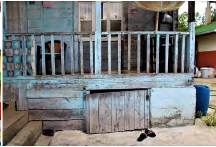
Görsel 4.229. Alan Köyü Celalettin Somuncu Evi güney cephe
