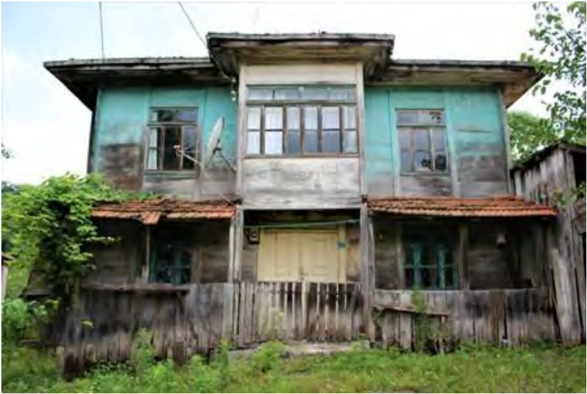
Görsel 4.133. Alan Köyü Muhittin Şensoy Evi ön cephe
