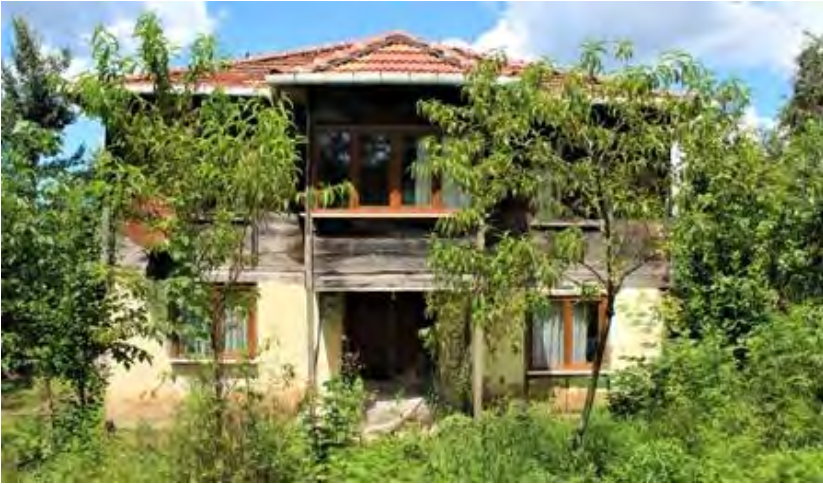
Görsel 4.316. Karacaören Köyü Ali Tokatlıoğlu Evi ön cephesi
