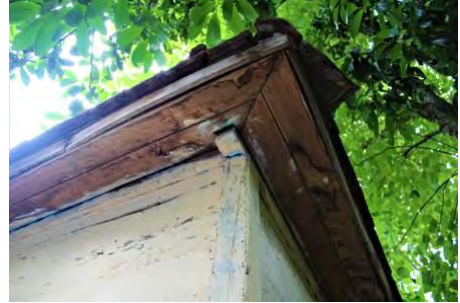
Görsel 4.115. Alan Köyü Dursun Susoy Evi çatı saçağı
