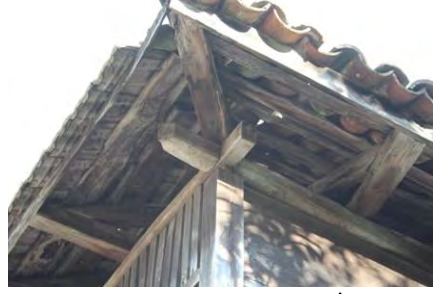
Görsel 4.455. Alan Köyü İsmet Şensoy Sereni çatı saçağı
