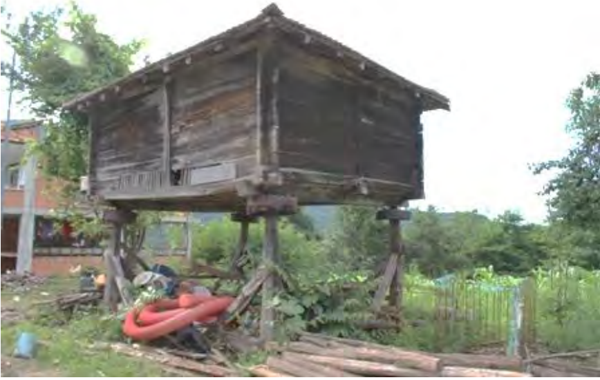
Görsel 4.529. Karacaören Köyü Hasan Şahin Sereni güney ve doğu cephesi
