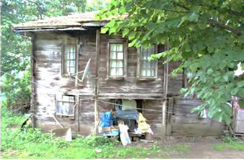
Görsel 4.260. Karacaören Köyü Hüseyin Tokatlıođlu Evi dođu cephesi
