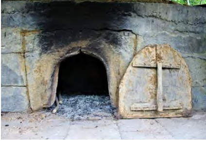
Görsel 4.658. Karacaören Köyü Muhammer Çakır Fırını pişirme hücresi ağzı
