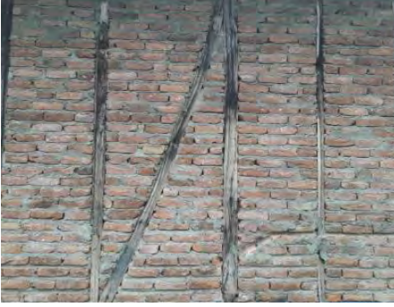
Görsel 5.147. Salıpazarı Fındıklı Köyü Kemal Güven Evi tuğla dolgulu ahşap karkas duvar detay (Salih Akkuzu Arşivi)
