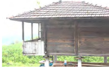
Görsel 5.145. Salıpazarı Çiçekli Köyü'nden ahşap yığma duvarlı seren örneği
