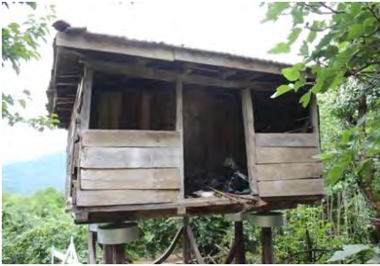
Görsel 4.388. Alan Köyü Resul Zengin Sereni ön cephesi
