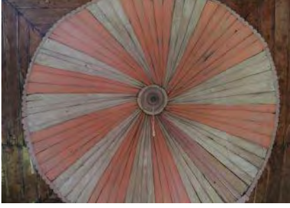
Görsel 5.149. Salıpaazarı Cevizli Köyü Camii harim kubbesi
