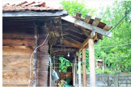
Görsel 4.126. Alan Köyü Mahmut Bal Evi çatı saçağı
