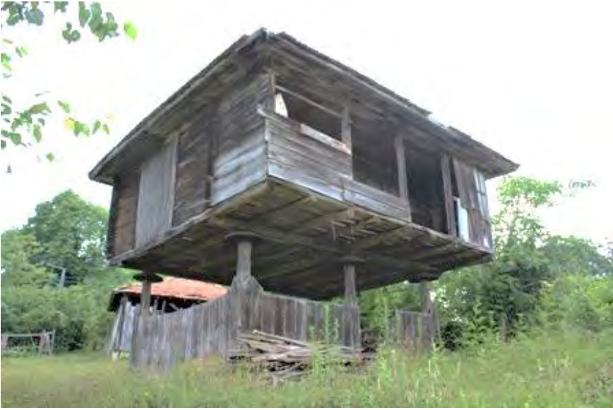
Görsel 4.509. Alan Köyü Muhittin Şensoy Sereni güney ve doğu cephesi
