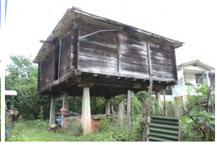
Görsel 4.538. Karacaören Köyü İlyas Keskin Sereni doğu cephesi
