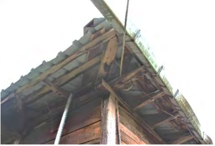
Görsel 4.373. Karaman Köyü Cemal Keleş Evi çatı saçağı (kaplamasız)
