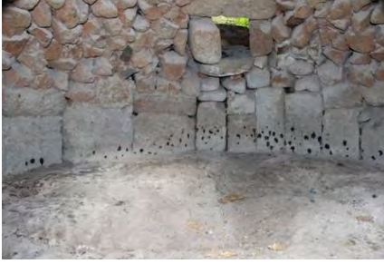
Görsel 4.674. Karacaören Köyü İbrahim ve Necmi Tekin Fırını pişirme hücresi tabanı (üstte baca ağızı)
