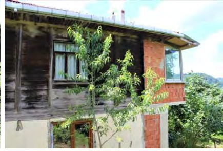
Görsel 4.319. Karacaören Köyü Ali Tokatlıođlu Evi dođu cephesi
