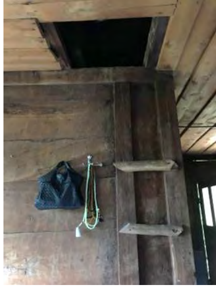
Görsel 5.209. Karacaören Köyü Muhammer Çakır Evi çatı arasına çıkış merdiveni
