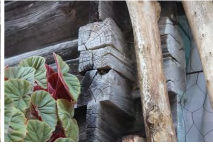
Görsel 4.309. Karacaören Köyü İbrahim Tekin Evi kuzeydoğu köşe kat kirişi
