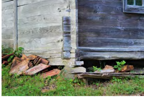
Görsel 4.104. Karacaören Soyuk Mahallesi İlkokulu güneybatı köşe taş temel
