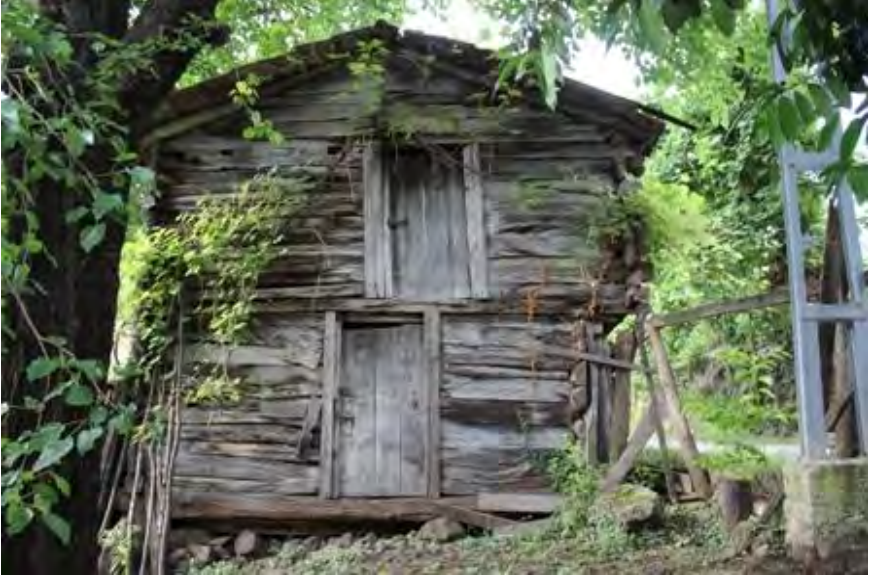
Görsel 4.691. Karacaören Köyü Duran Tekin Samanlığı ön cephesi
