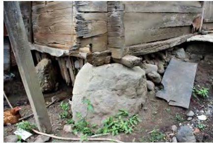
Görsel 4.206. Alan Köyü Kemal Gür Evi kuzeydoğu köşe taş temel
