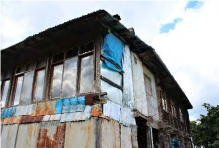
Görsel 4.381. Karaman Köyü Yusuf Keleş Evi ön cephesi üst kat
