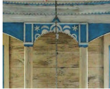
Görsel 5.237. Alan Köyü Camii iki direk arasındaki yarım daire dizilerinden oluşan kemer
