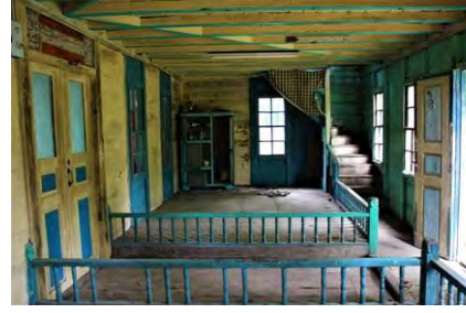
Görsel 4.17. Alan Köyü Camii son cemaat mahalli batı yönü
