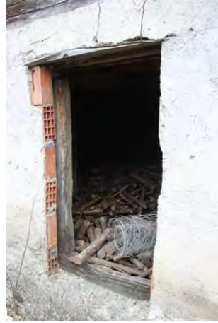
Görsel 4.124. Alan Köyü Mahmut Bal Evi zemin kat girişi
