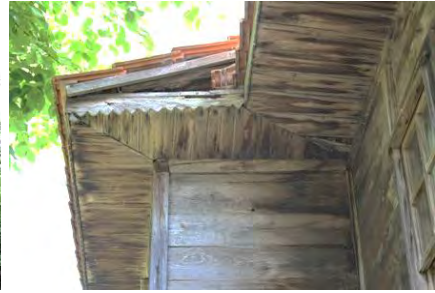
Görsel 4.266. Karacaören Köyü Hüseyin Tokatlıoğlu Evi çatı saçağı
