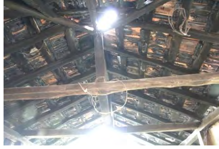
Görsel 4.622. Alan Köyü Sabahattin Somuncu Fırını çatısı içten görünüm
