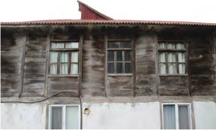
Görsel 4.238. Alan Köyü Resul Zengin Evi batı cephesi
