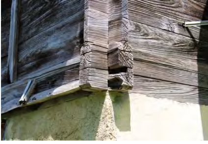
Görsel 4.322. Karacaören Köyü Ali Tokathoğlu Evi güneybatı kat kirişi
