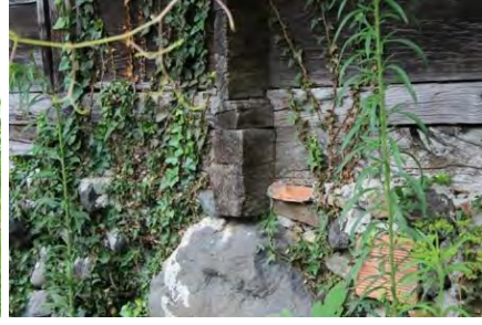
Görsele 4.135. Alan Köyü Muhittin Şensoy Evi güney cephe taş temel ayrıntısı
