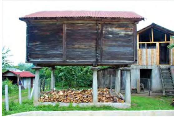
Görsel 4.562. Karaman Köyü Yusuf Keleş Sereni batı cephesi
