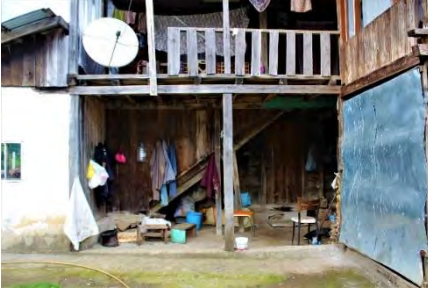
Görsel 4.379. Karaman Köyü Yusuf Keleş Evi ön cephesi alt kat
