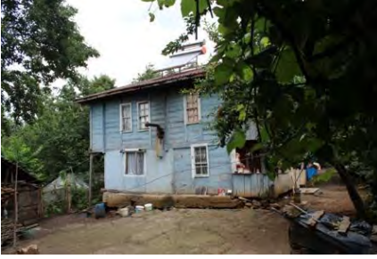
Görsel 4.193. Alan Köyü Yusuf Arslan Evi güney cephesi
