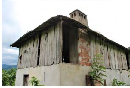
Görsel 4.699. Alan Köyü Muhittin Şensoy Ahırının kuzey ve doğu cephesi
