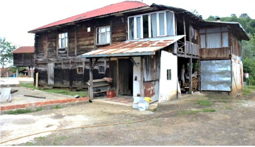
Görsel 4.378. Karaman Köyü Yusuf Keleş Evi batı ve güney cephesi
