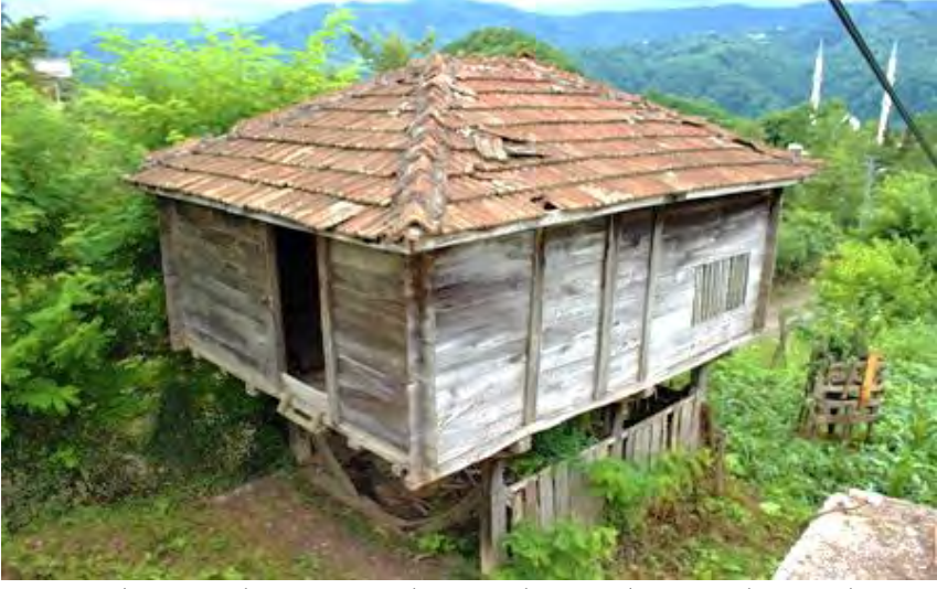
Görsel 4.491. Alan Köyü Mahmut Bal Sereni kuzey ve batı cephesi
