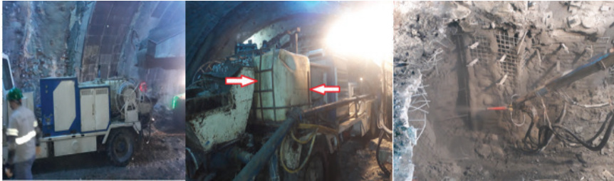
Şekil 5: Tünelmak Adroit 430 Robot (shotcrete) İş Makinası ile Püskürme Beton Uygulaması
