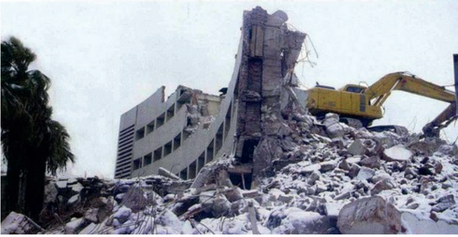
Şekil 13. Kervansaray Oteli yıkım esnasında (URL 2)
