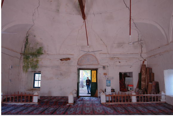
Resim 3. Güney cephesi iç mekanı
