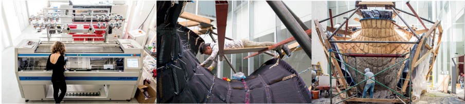
Şekil 5. Knit Candela kumaş üretimi, kalıp gerilimi, beton dökümü aşamaları (URL-4, URL-5)
